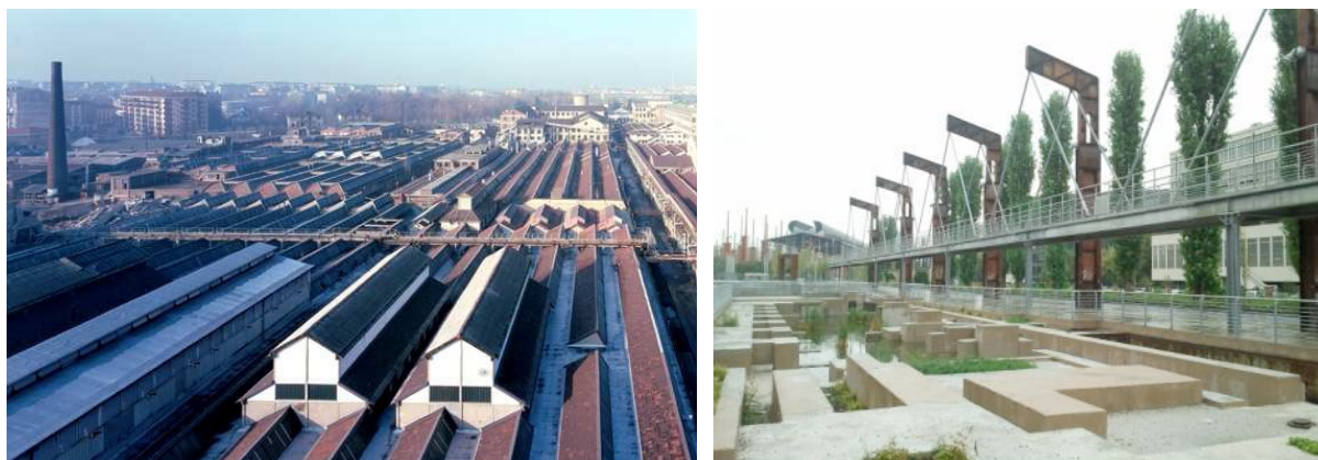
Figura 1. Da sinistra. L'insediamento prima della trasformazione; il parco ha preso il posto dell'insediamento industriale che ha lasciato traccia di sé con il permanere di alcuni manufatti ritenuti emblematici della sua esistenza: la palazzina 37, la torre evaporativa insieme ai monconi metallici di alcuni capannoni. Foto: Vigliocco, 1999, 2012.
