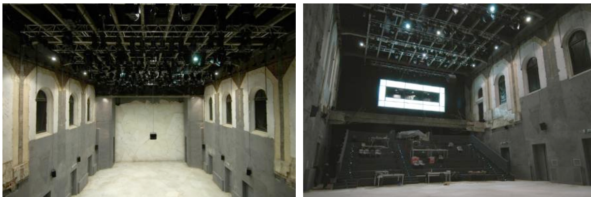
Figura 6. La sala teatrale dopo l'intervento: le murature sono state conservate così come sono state trovate al momento dell'avvio della progettazione. Fatta eccezione degli apparati scenotecnicici, impiantistici e di adeguamento funzionale, il manufatto è stato conservato e implementato con apparati neutri. Foto: Biamino, 2006.
