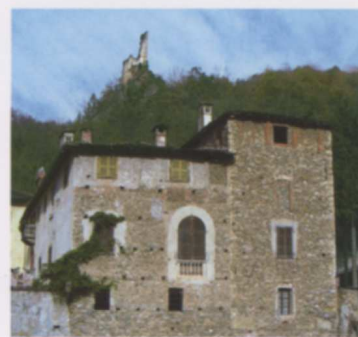
▲ Particolare del complesso addossato alla casaforte
