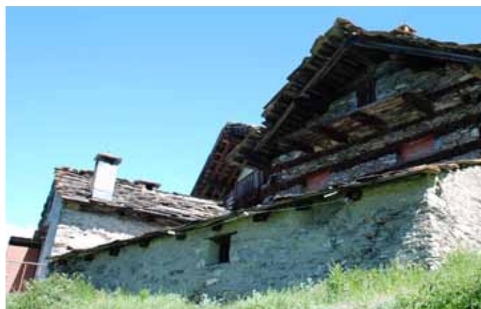
Muratura mista in pietra a secco e travi in legno, Montagne Seu
