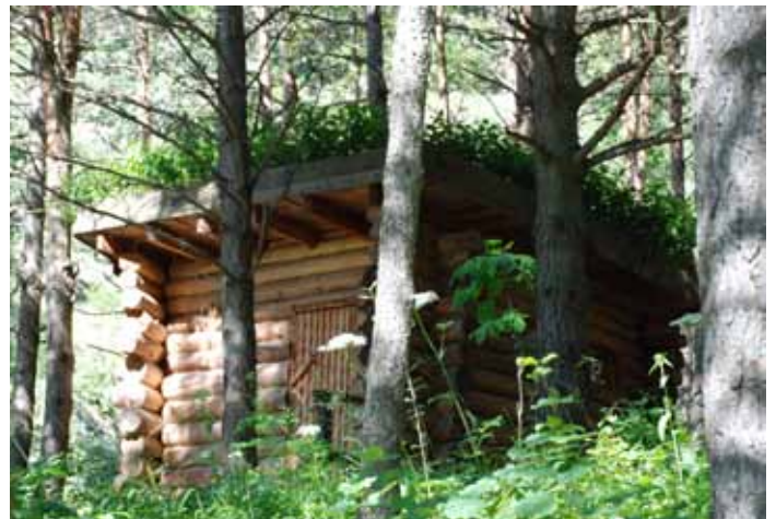
Salbertrand, Smoke Sauna realizzata sotto il progetto del DIPRADI "Il bosco come risorsa: la costruzione nel bosco".
