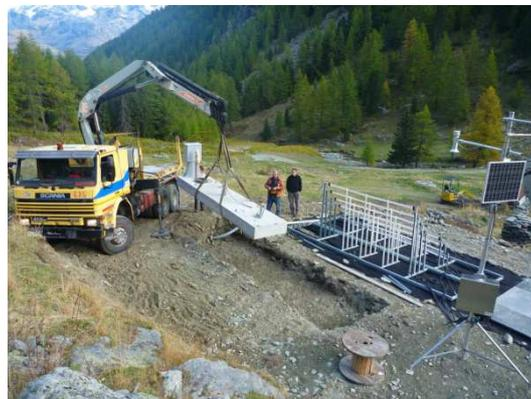
**FIGURA 83: POSIZIONAMENTO PLINTO**
