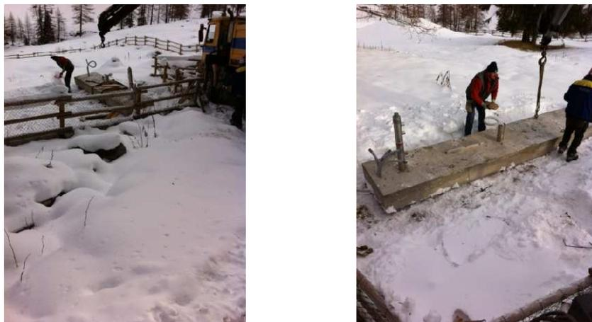
FIGURA 68: POSIZIONAMENTO DEL PLINTO
