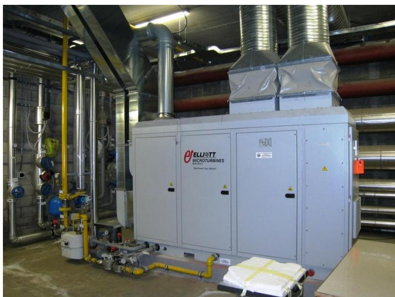
Figura 2-3 - Foto della microturbina installata presso l'EcoEner.Lab del Politecnico di Torino
