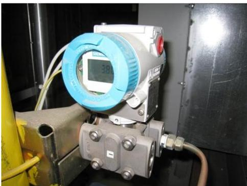
Figura 2-36 - Misuratore pressione gas pb
