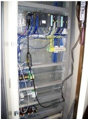
Figura 2-30 - Controllore Siemens dell'impianto MGT-A
