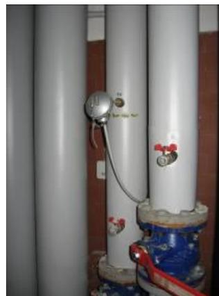
Figura 2-53 - Sensore di temperatura acqua calda alle unità desiccant
