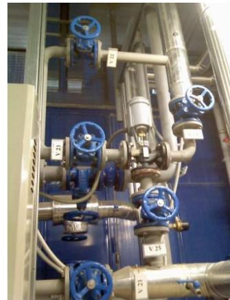
Figura 2-21 - Particolare della valvola di regolazione a tre vie dell'assorbitore
