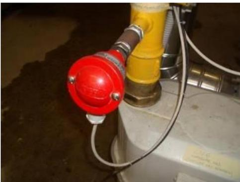
Figura 2-38 - Sensore temperatura gas T3
