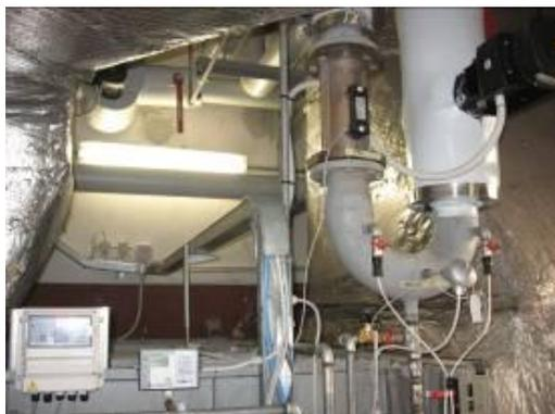
Figura 2-52 - Misuratore portata d'acqua del circuito di torre
