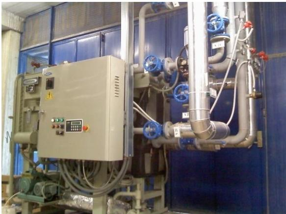
Figura 2-20 - Assorbitore di calore: piping di collegamento
