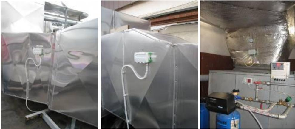
Figura 2-56 - Sensori di temperatura e umidità nei canali dell'aria di mandata
