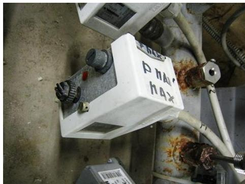
Figura 2-43 - Pressostato di massima
