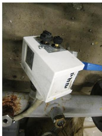
Figura 2-45 - Pressostato di minima
