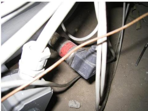
Figura 2-42 - Flussostato
