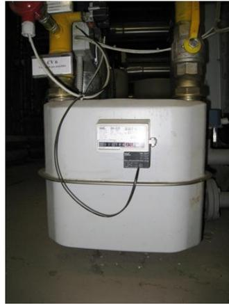
Figura 2-35 - Misuratore volumetrico gas MFb
