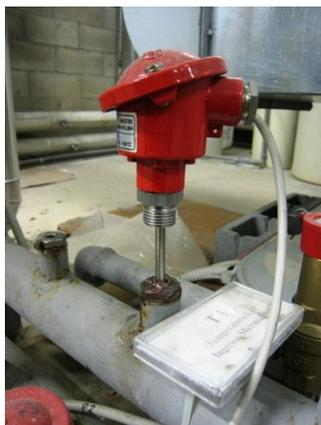
Figura 2-40 - Sonda di temperatura T1
