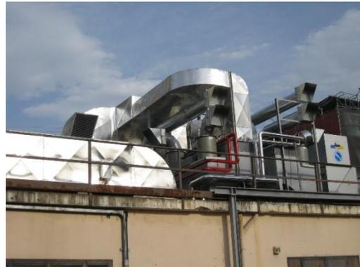
Figura 2-26 - Vista d'insieme delle unità desiccant
