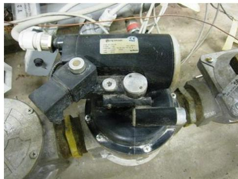
Figura 2-37 - Valvola intercettazione combustibile
