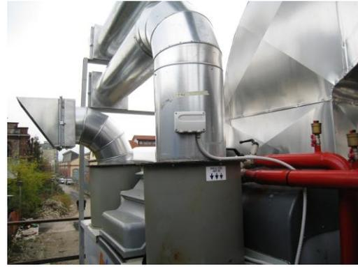
Figura 2-55 - Sensore di temperatura e umidità dell'aria all'ingresso di una unità desiccant
