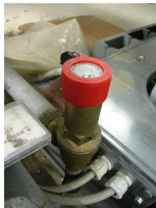
Figura 2-41 - Valvola di scarico termico
