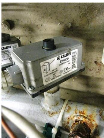
Figura 2-44 - Termostato ad immersione
