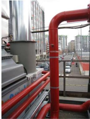
Figura 2-54 - Sensore di temperatura dell'acqua di ritorno in torre
