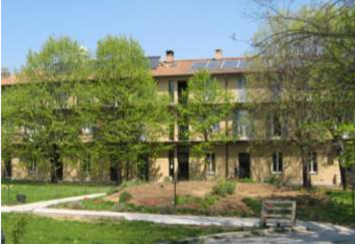
Fig. 1: la manica ristrutturata secondo principi di maggiore sostenibilità
