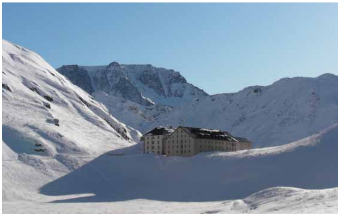
Figura 2.2.10 : Veduta dell'Hospice du Grand-Saint- Bernard
