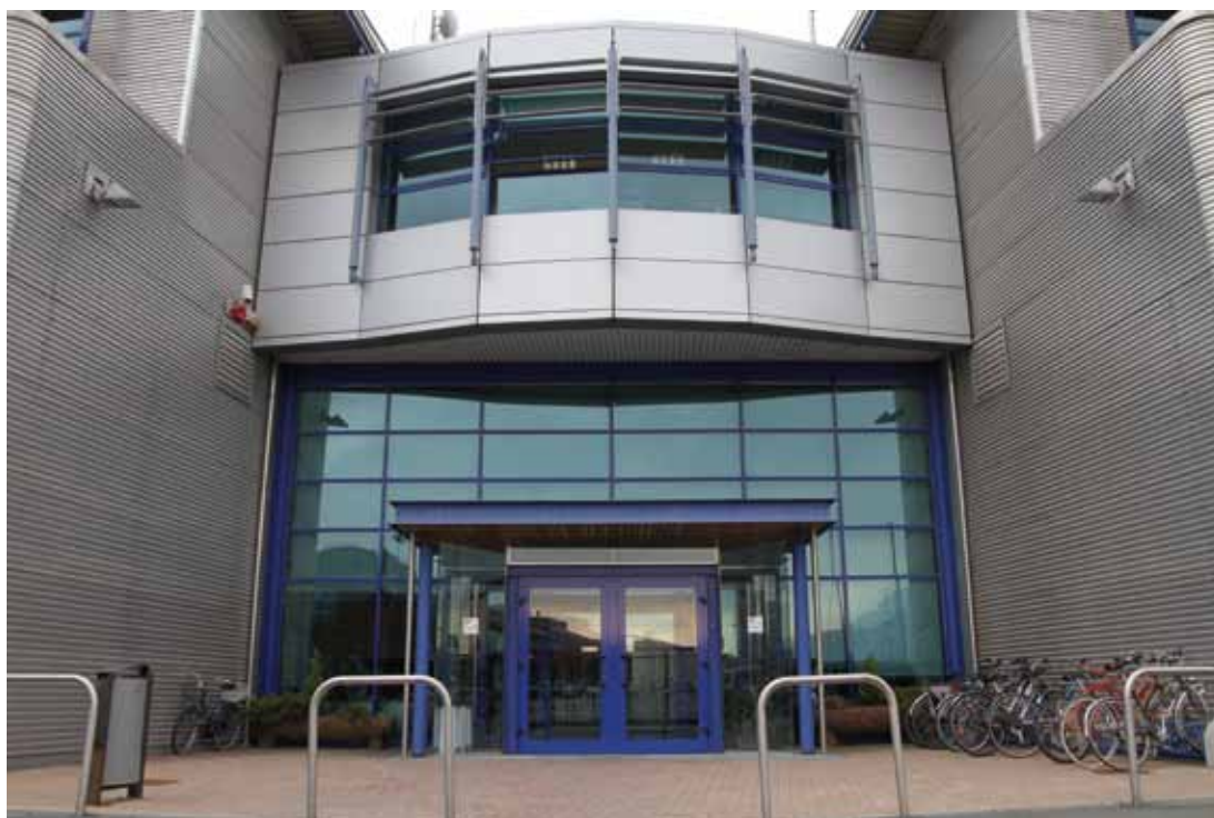
Figura 2.1.11: Pépinière d'Entreprises dell'area industriale Espace Aosta
