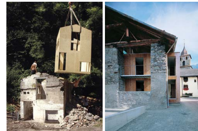
[Figg. 29-30 - 29) Recupero di una stalla, inserimento di una nuova struttura all'interno. Progettista: naumannnaumann. architektur. 30) Bergün, Grigioni (Svizzera). Recupero di edificio storico, inserimento di una nuova struttura all'interno.
