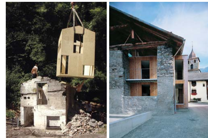
[Figg. 29-30 - 29) Recupero di una stalla, inserimento di una nuova struttura all'interno. Progettista: naumannnaumann. architektur. 30) Bergiun, Grigioni (Svizzera). Recupero di edificio storico, inserimento di una nuova struttura all'interno.
