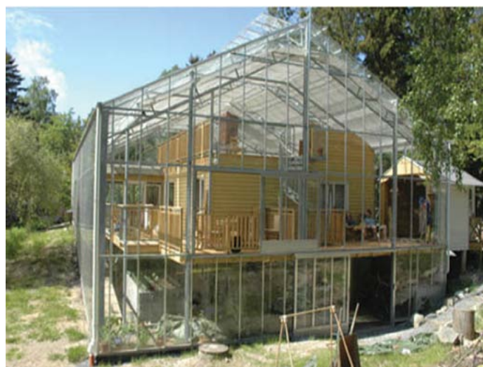
[Fig. 13 - "Naturhuset" a Vänersborg, Svezia, arch. Bengt Warne - la serra attorno all'edificio forma una zona intermedia di temperatura tra l'ambiente interno e quello esterno, grazie agli apporti passivi]
