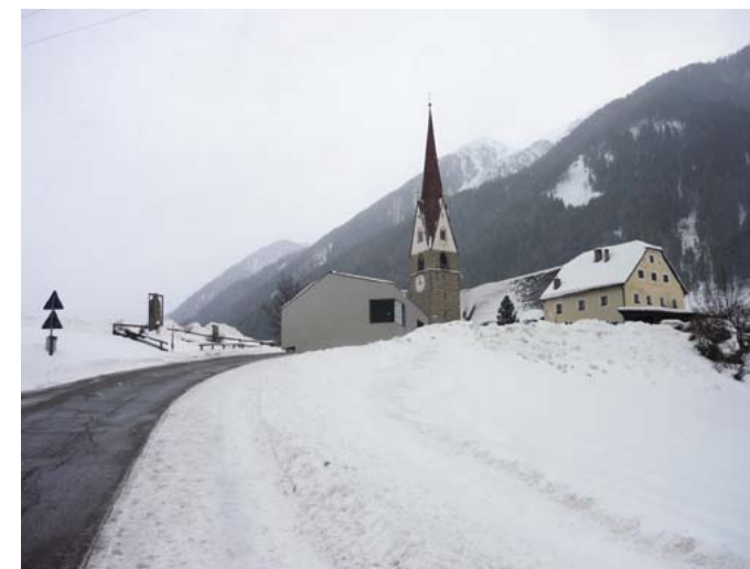
[Fig. 20 - edificio polifunzionale "am Buhel", architetti Mutschlechner & Mahlknecht - Comune di S. Giacomo - Valle Aurina (BZ) - foto Nadia Battaglio]
