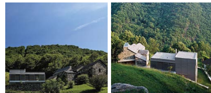
[Figg. 31-32 - Pianezzo, Ticino (Svizzera) - Recupero gruppo di case per spazi espositivi e atelier artistico, inserimento di nuovo fabbricato ad uso residenziale. Progettista: Michele Arnaboldi. Intervento contemporaneo in contiguità con l'esistente: compatibilità e distinzione tra l'esistente e il nuovo intervento.
