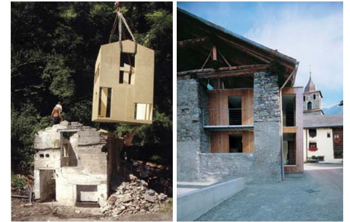
[Figg. 29-30 - 29) Recupero di una stalla, inserimento di una nuova struttura all'interno. Progettista: naumannnaumann. architektur. 30) Bergiun, Grigioni (Svizzera). Recupero di edificio storico, inserimento di una nuova struttura all'interno.
