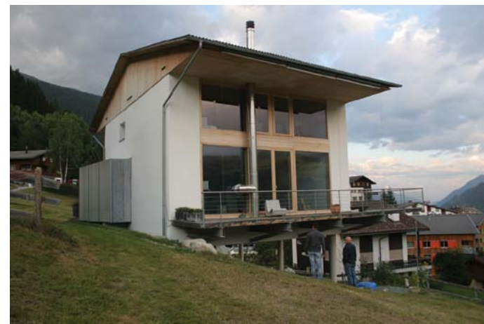
[Fig. 4 - arch. Werner Schmidt, Haus Braun, Disentis, Grigioni realizzata con le pareti perimetrali in paglia - foto Andrea Bocco]
