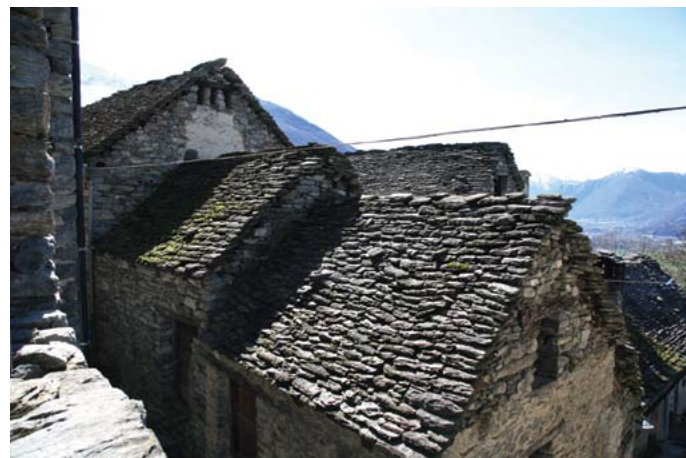
[Fig. 5 - coperture in pietra - foto Lorenzo Serra]
