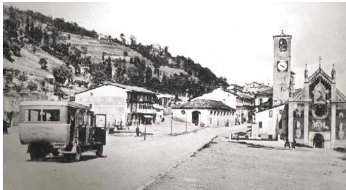
[Fig. 4 - foto storica di piazza della Vittoria - fonte archivio storico di Sampeyre]
