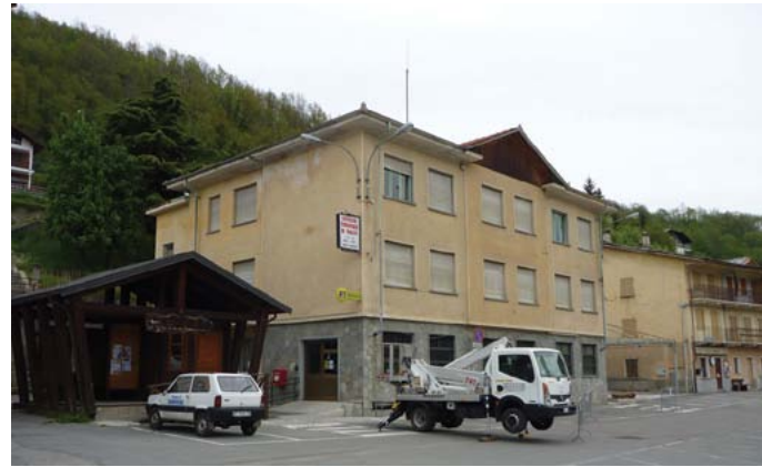
[Fig. 6 - foto dell'ex scuola di Sampeyre, vista da fronte piazza (sud-ovest) - foto Andrea Bocco]
