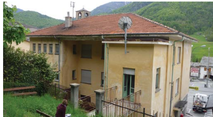
[Fig. 7 - foto dell'ex scuola di Sampeyre, vista da monte (nord-ovest) - foto Andrea Bocco]
