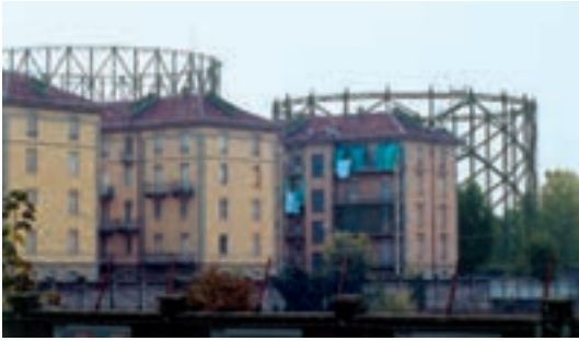
181. Il quartiere 7 dello IACP visto da nord; dietro di esso i due gasometri.
