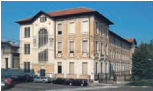
182. La testata sud della scuola Muratori.
