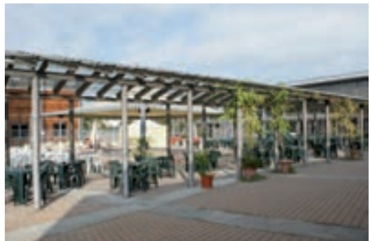
60. La piazza dei servizi del PIP di Collegno.
