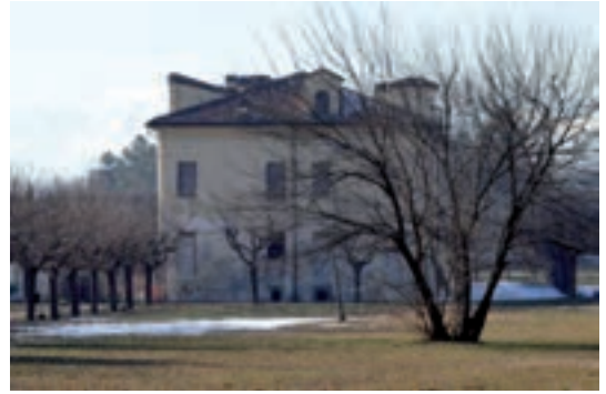
86. Fronte est della cascina Marchesa.
