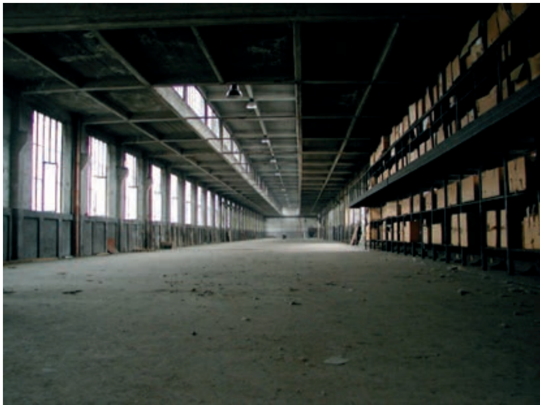
127. Il secondo piano della porzione che è stata conservata dello stabilimento SNOS, prima dei lavori di ristrutturazione.
