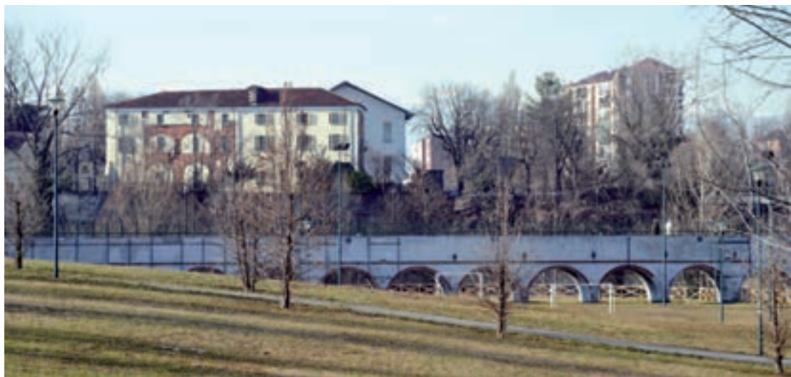
94. Il canale della Ceronda correva dentro la conduttura che attraversa gli attuali giardini di via Calabria. Sullo sfondo, dall'altra parte della Dora, il castello di Lucento con archi di mattoni in facciata.
