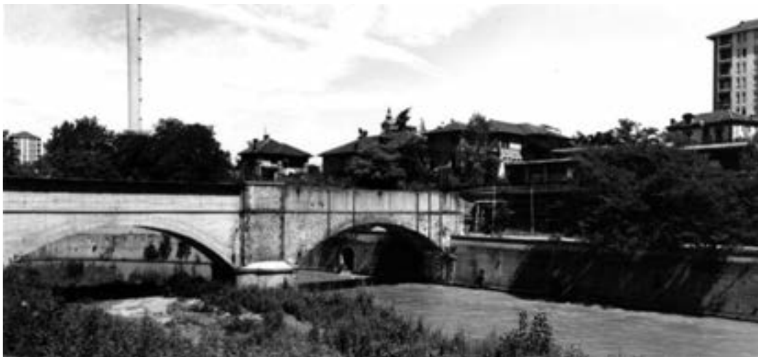
Il ponte del ramo destro del canale della Ceronda, subito a valle del castello di Lucento.
