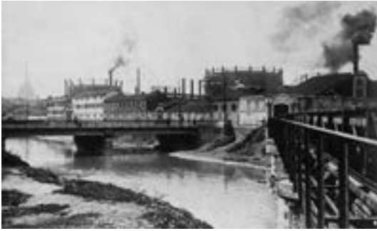
155. Ponte Bologna, gasometro di borgo Dora e ponte del Carbone (a destra) in una foto di inizio Novecento. Comparare con la foto a p. 106, che mostra la medesima inquadratura oggi.
