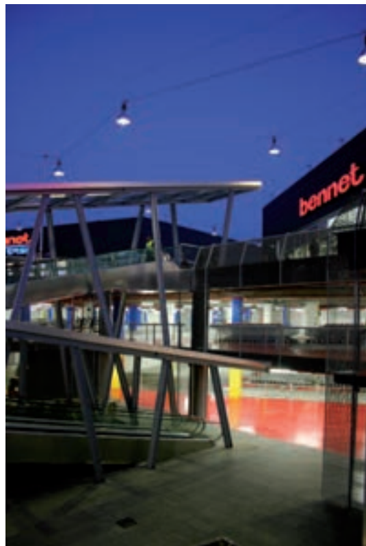
123. Parcheggio ed edifici per il commercio del "Vitali Park".
