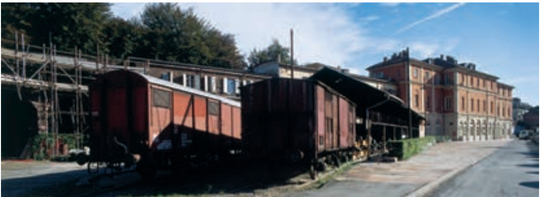
146. Il piazzale della stazione Porta Milano si trova alcuni metri più in basso di corso Giulio Cesare. Sulla sinistra, la rimessa locomotive; sulla destra il fabbricato viaggiatori.
