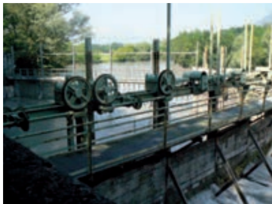
2. Presa della bealera Becchia, che alimenta la centrale idroelettrica di Alpignano.
