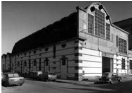
115. La porzione dell'ex stabilimento Metzger all'angolo delle vie Durandi e Pinelli.
