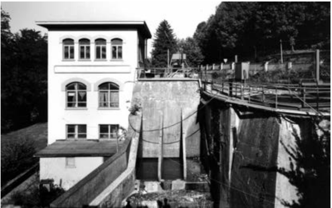
8. La centrale idroelettrica di Alpignano, ai piedi del castello.
