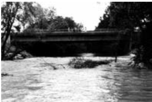
77. Il ponte Pietro II dall'acqua.
