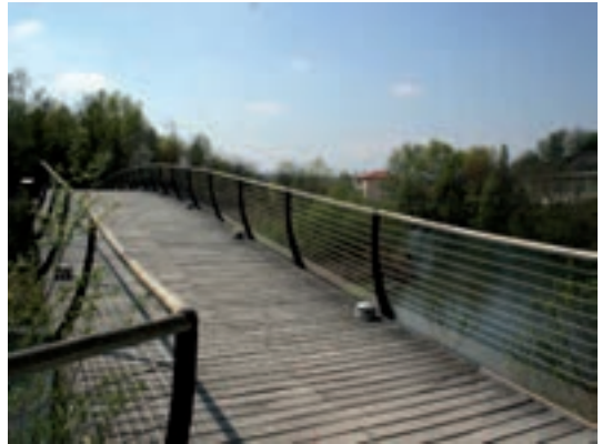
29. L'imbocco della passerella ciclopedonale dalla sponda sinistra.
