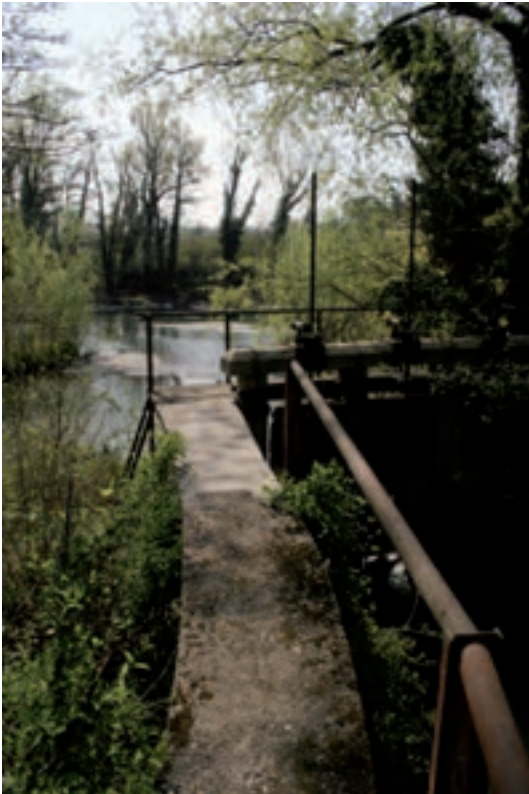
31. La paratia dello scaricatore delle bealere di Collegno e Barola.
