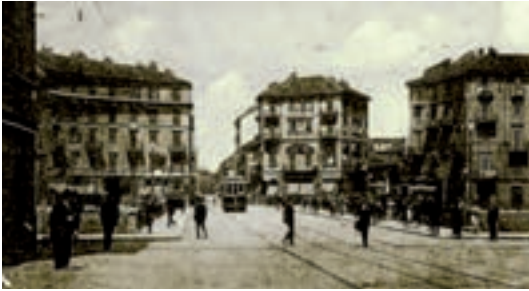
176. Il ponte Rossini e gli edifici che costituiscono l'esedra di via Reggio.
