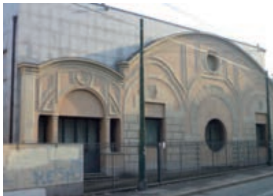
137. La facciata superstite del “giuoco boccie” Durio, inglobata nel nuovo edificio.
