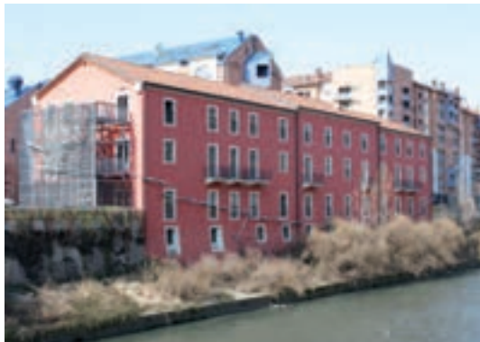
134. L'edificio della ex conceria Durio oggi trasformato in biblioteca "Calvino".
