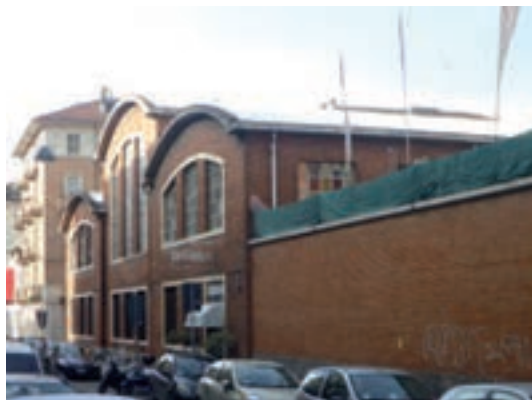
119. La porzione di ex birreria Bosio & Caratsch su via Pinelli.
