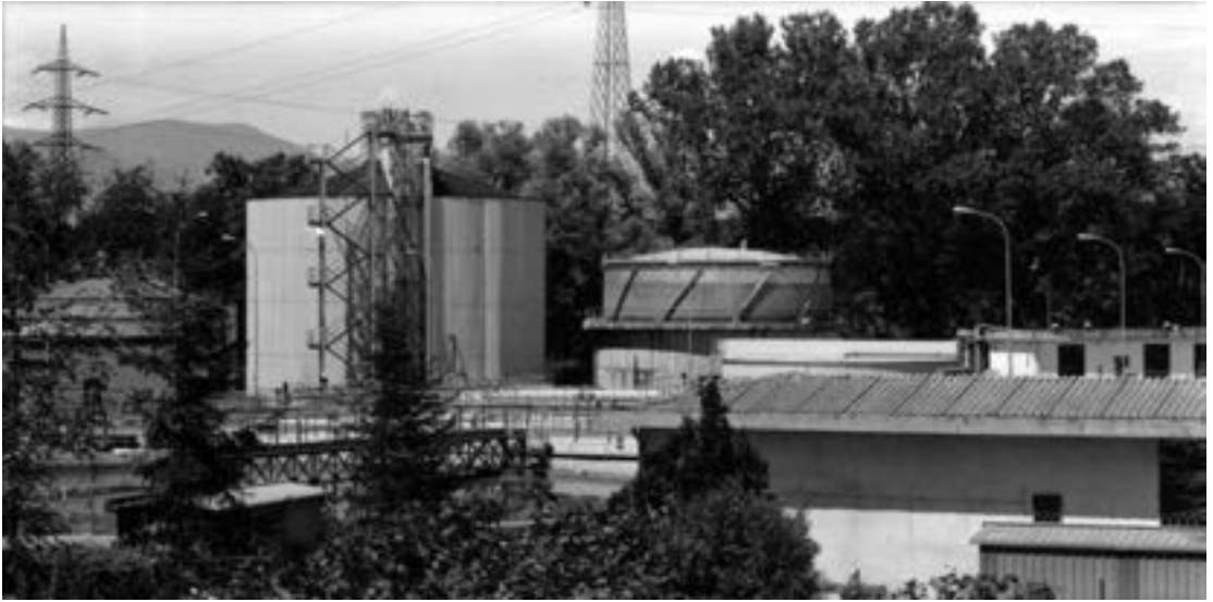
67. Il depuratore SMAT delle Basse di Dora sorge su un'ansa, a ridosso della Dora.
