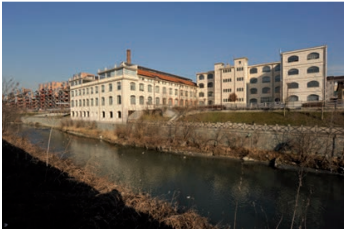
101. La ex fabbrica Paracchi restaurata e il percorso pubblico lungo fiume visti dalla sponda destra.
