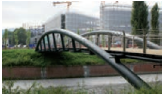
180. La nuova passerella pedonale; sullo sfondo la sede universitaria in costruzione.
