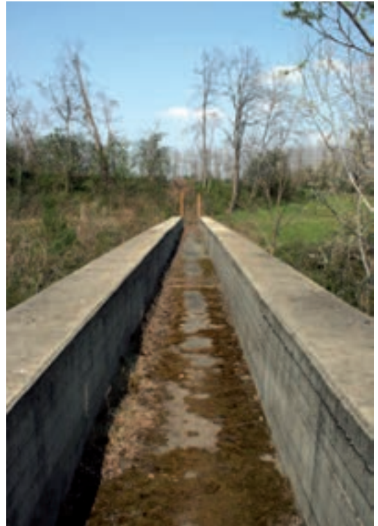
37. La passerella a valle del mulino della Barca, guardando verso nord.
