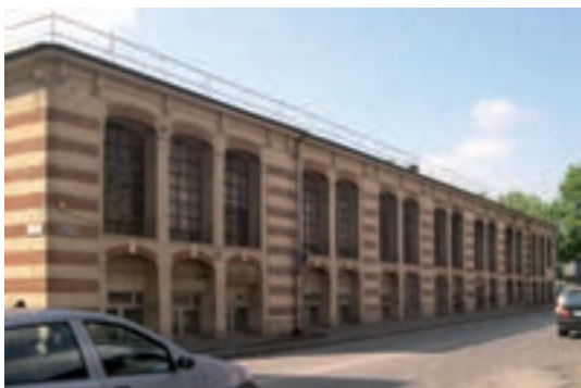
158. Porzione dello stabilimento FIAT Grandi Motori che occupa l'isolato a nord di via Pinerolo, visto da via Cigna.
