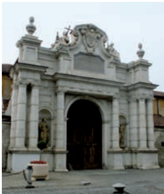
52. Il portale juvarriano della certosa recentemente restaurato.
