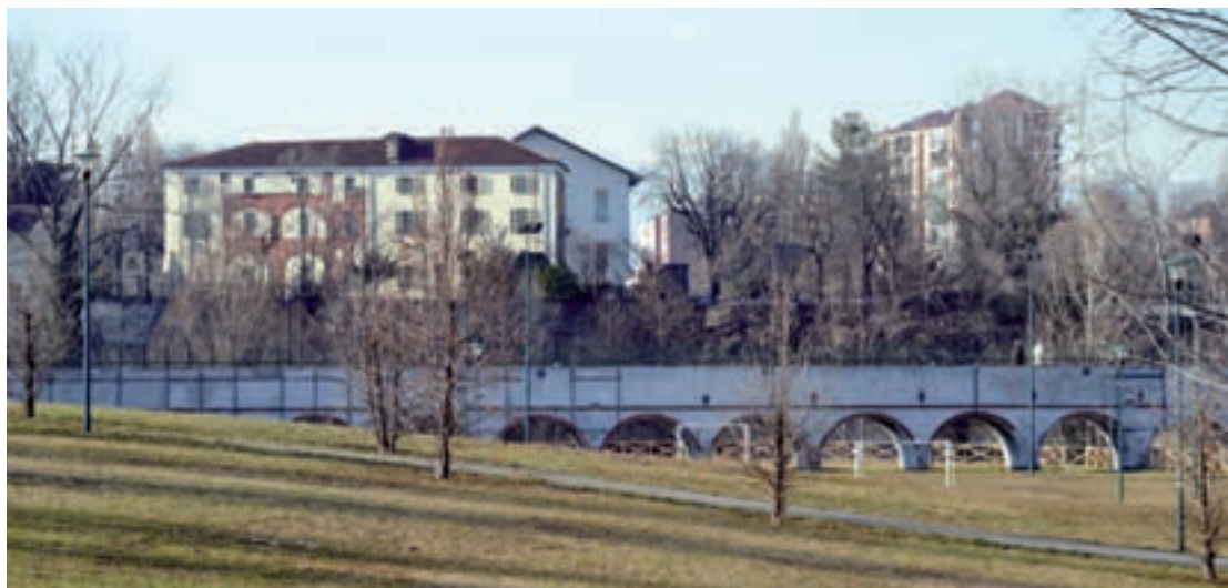
94. Il canale della Ceronda correva dentro la conduttura che attraversa gli attuali giardini di via Calabria. Sullo sfondo, dall'altra parte della Dora, il castello di Lucento con archi di mattoni in facciata.
