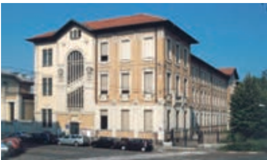
182. La testata sud della scuola Muratori.
