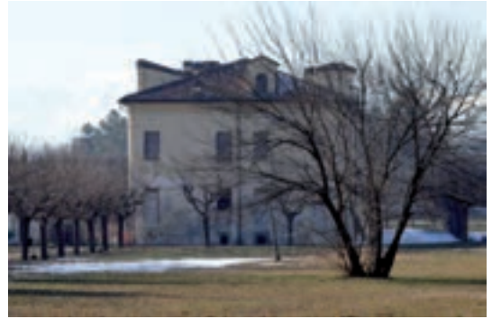
86. Fronte est della cascina Marchesa.
