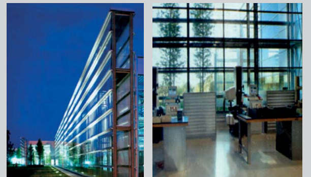
Inserimento di soluzione a doppia pelle per aumentare il comfort interno.
