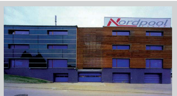
Inserimento di pannelli solari termici in facciata in una operazione di recupero di fabbricati produttivi esistenti.
