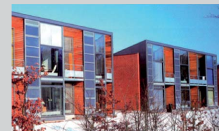
Inserimento di serre e pareti di accumulo
