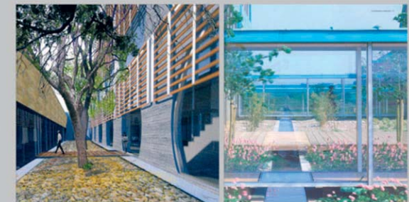
Articolazione delle superfici esterne e uso di materiali adeguati per assicurare la regolazione del microclima.
