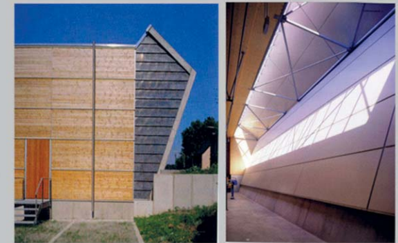
Superfici vetrate inclinate poste nelle coperture dei fabbricati portano la luce riflessa nelle zone interne ove non sia possibile praticare aperture nelle facciate.
