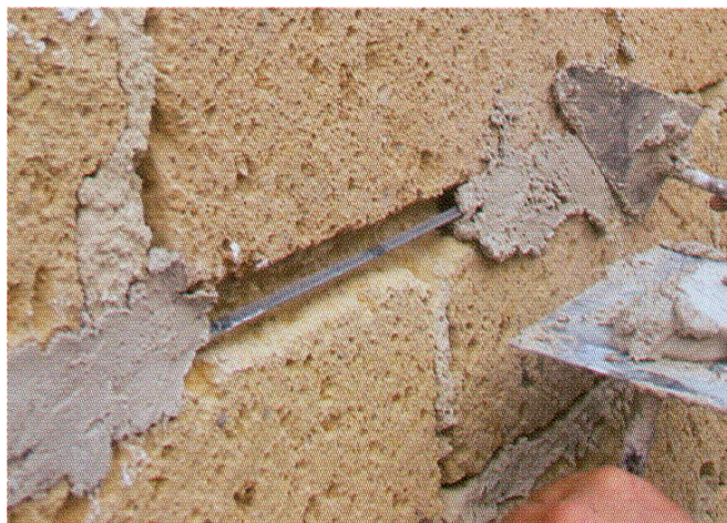
Figura 1.10 – Posizionamento longitudinale delle barre lungo i giunti di malta
