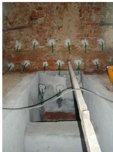
Figura 1.3 – Esempi di iniezioni su murature
