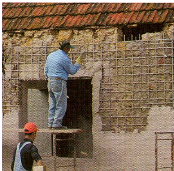
Figura 1.5 – Applicazione dell'intonaco armato
