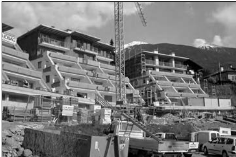
Cantiere di edilizia residenziale bioclimatica a Bressanone
