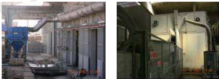
Fig.3: Taglio blocchi con telai multilame in box con aspirazione
