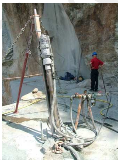
Fig.2: Perforatrice meccanica con spurgo d'acqua
