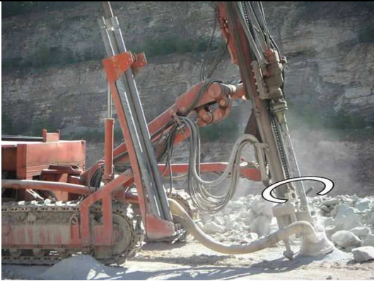
Fig.3 Perforatrice meccanica con aspirazione a boccaforo
