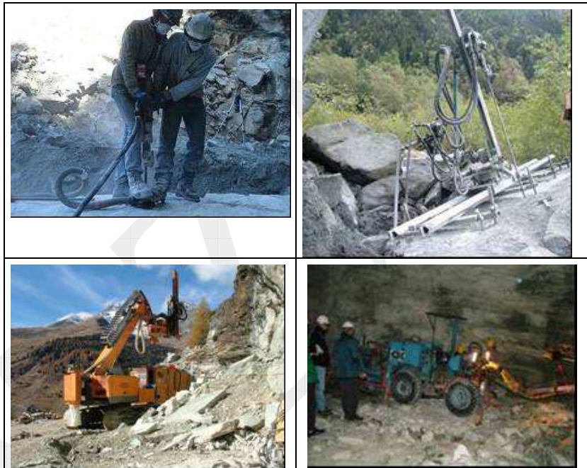
Fig.1: Perforazione con perforatrici manuali e meccaniche a secco e ad umido
