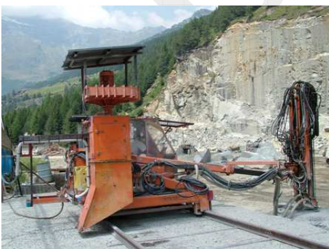
Fig.4: Perforatrice meccanica cabinata con spurgo d'acqua
