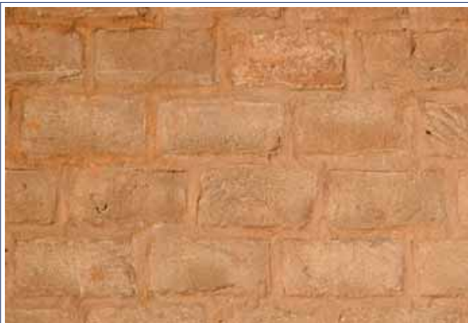
Castello di Racconigi, particolare, tessitura muraria degli ampliamenti ottocenteschi.
