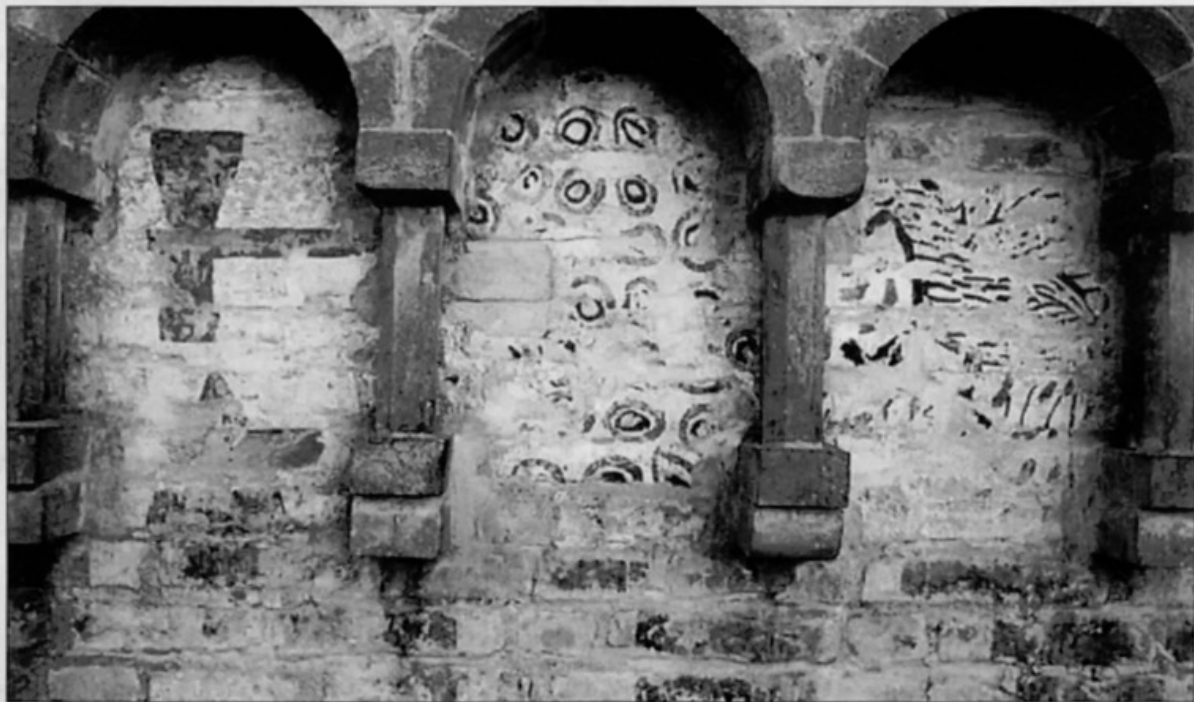
Parma, Palazzo vescovile: decorazioni in cotto, realizzate nel 1930 sul modello della basilica di Aquileia, sovrapposte all'intonaco dipinto duecentesco
