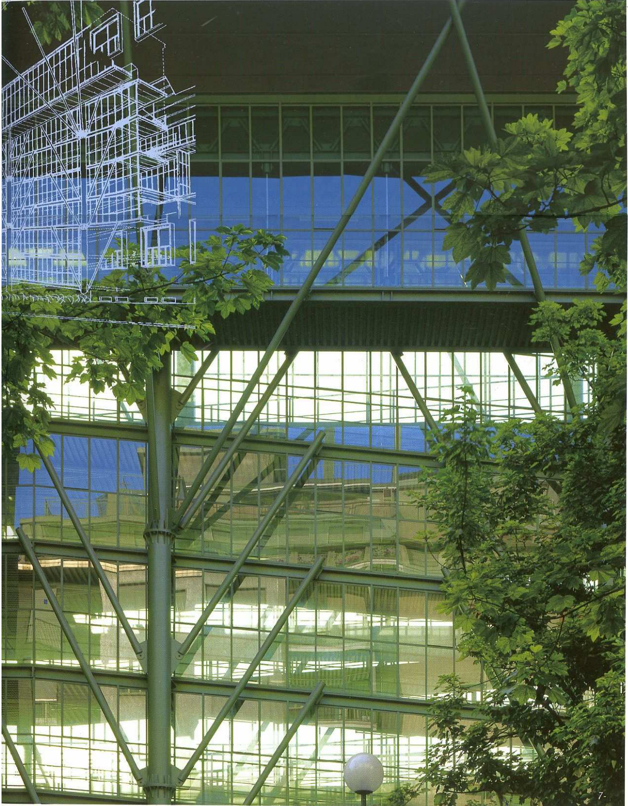
7- Due dei quattro piloni d'acciaio che sorreggono le rampe e, in alto, il tetto.
