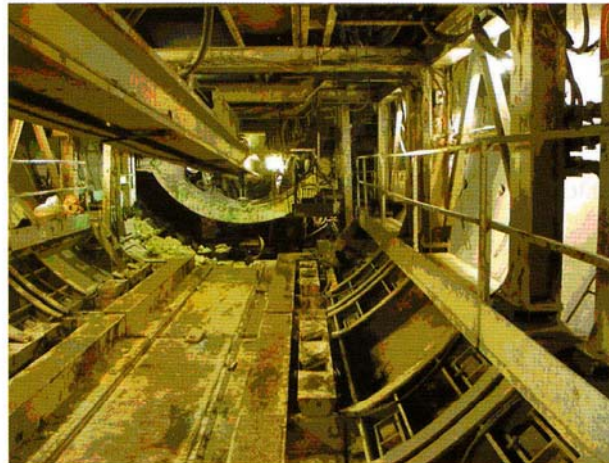
La figura n.3 muestra la descarga del segmento y su transporte al área del montador. Las trayectorias laterales estrechas conducen al frente, evitando el espacio ocupado por los segmentos.
