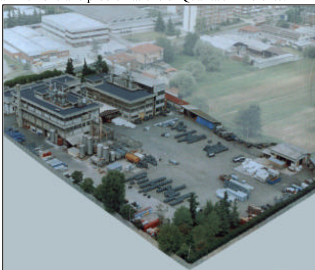
Figura 1 - Veduta aerea della SEICI S.p.A.
