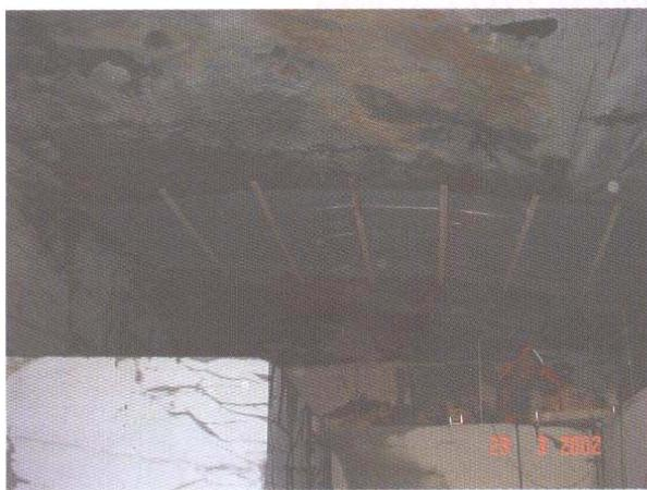
FIG. 9 - Dettaglio della discontinuità naturale che potrebbe originare un falso tetto nella cava.
