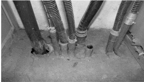
Figura 17 – Shaft Elétrico, Tubulação concretada na laje.
