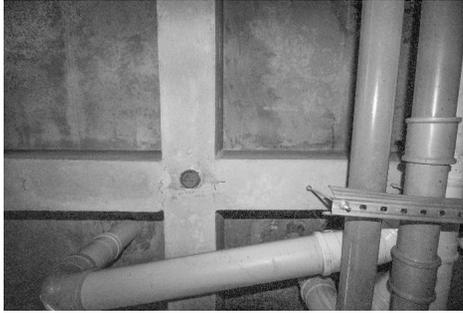
Figura 22 – Execução com furo na nervura para passagem de tubulação. Fonte: Acervo fotográfico do autor
