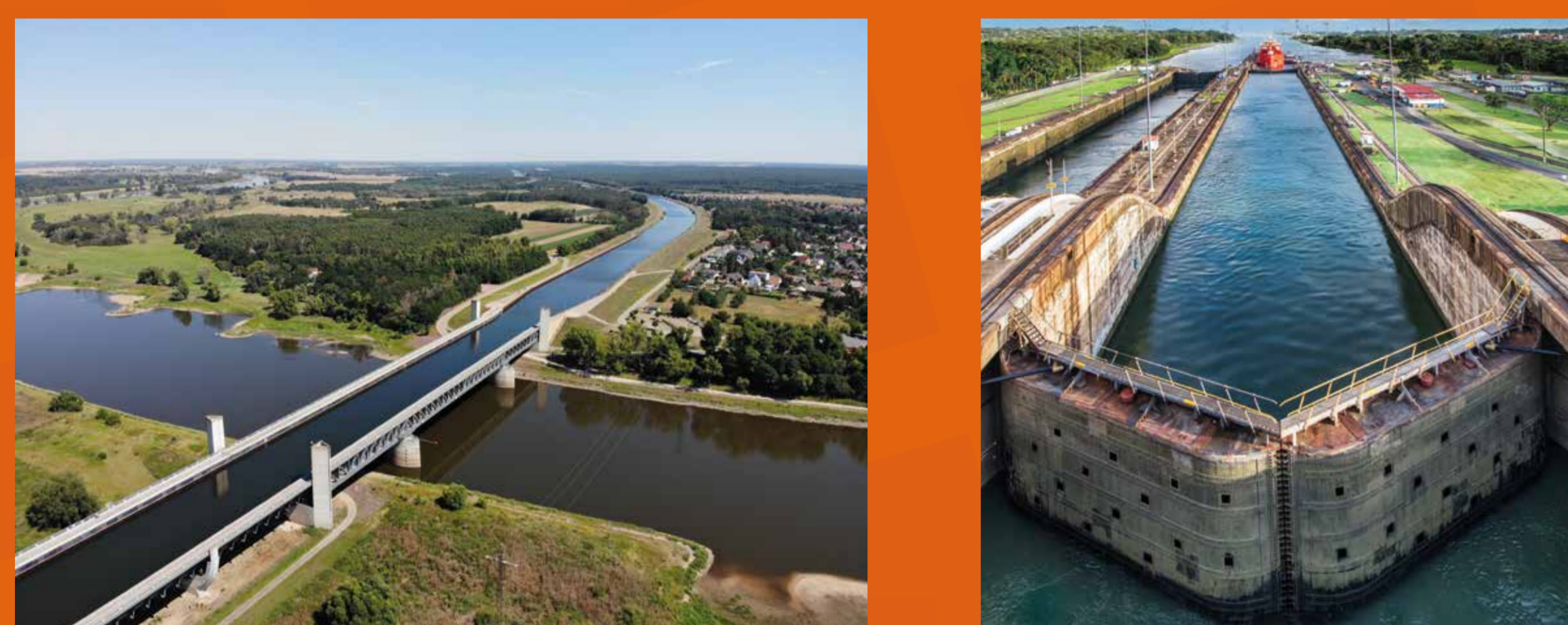
Ponte canale di Magdeburgo, Germania Canale di Panama, Panama
