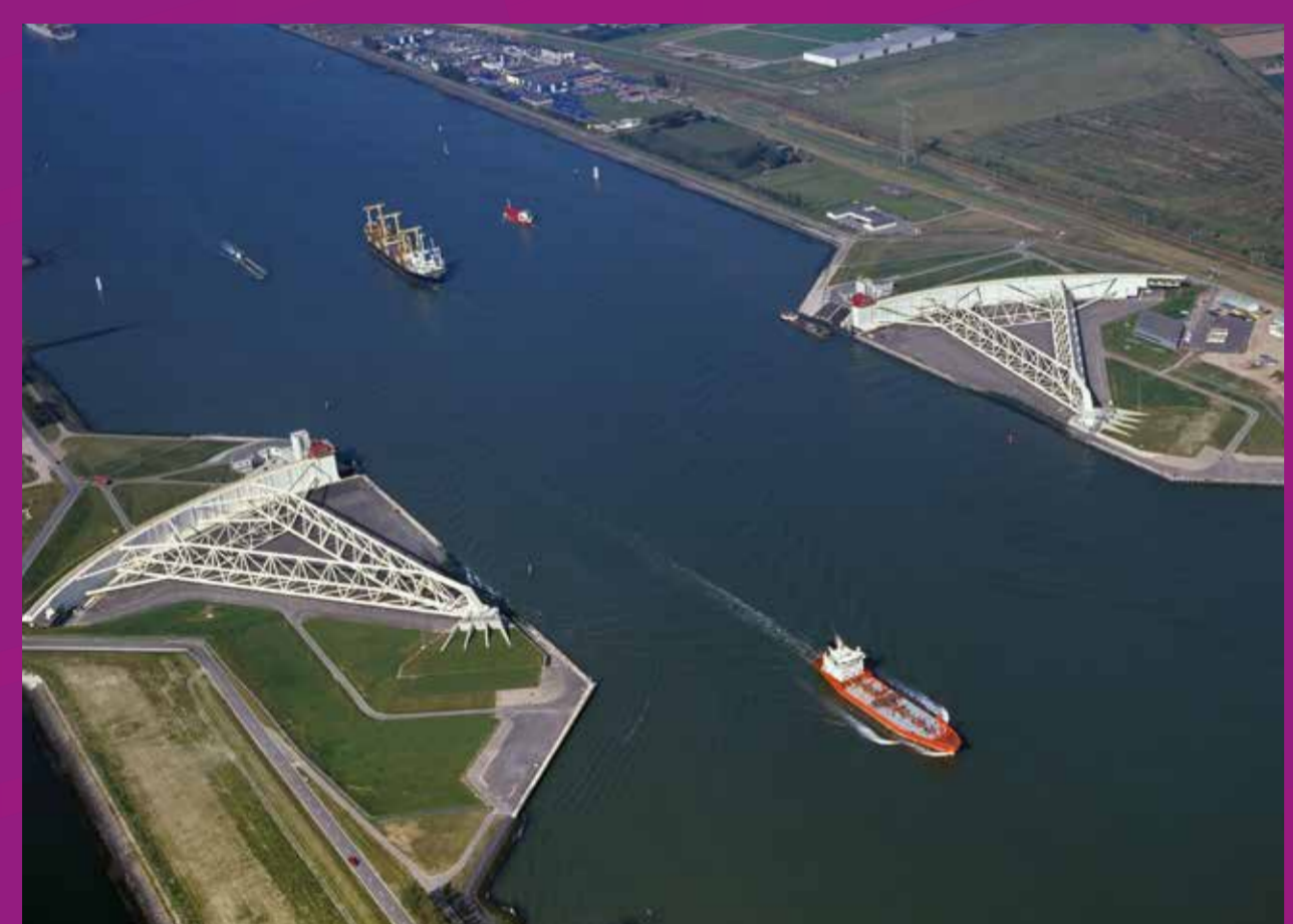
Maeslantkering, Hoek van Holland, Paesi Bassi
