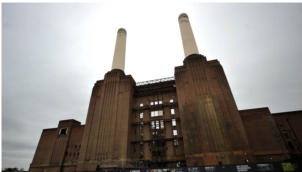
Figura 3. Il prospetto Nord della centrale. I muri perimetrali sono solo uno scheletro senza funzione.
