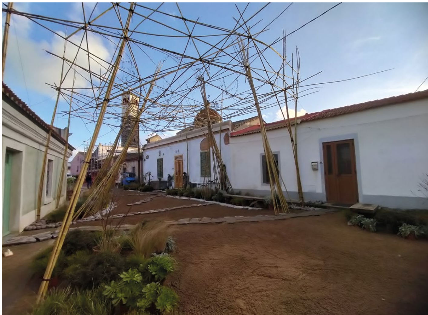
Fig. 3 - Il risultato finale dell'intervento di riqualificazione in un tratto urbano del centro di Cabras (OR).
