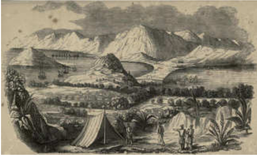
Fig. 1. Macao: al centro, l'originaria Porta do Cerco ( Guanzha in mandarino; Gwaan 1 zaap 6 in cantonese) e le relative mura, costruite da parte cinese nel 1573 o nel 1574 in corrispondenza di un accentuato restringimento dell'allora isola. Esse materializzavano il confine tra il Celeste Impero e il possedimento coloniale portoghese, riconosciuto come tale nel 1557-1558 e posto all'estremità meridionale della massa insulare (in primo piano). Incisione ottocentesca di E.T. Wigan, funzionale ad illustrare un episodio bellico della Prima Guerra dell'Oppio qui avvenuto nel 1840.
