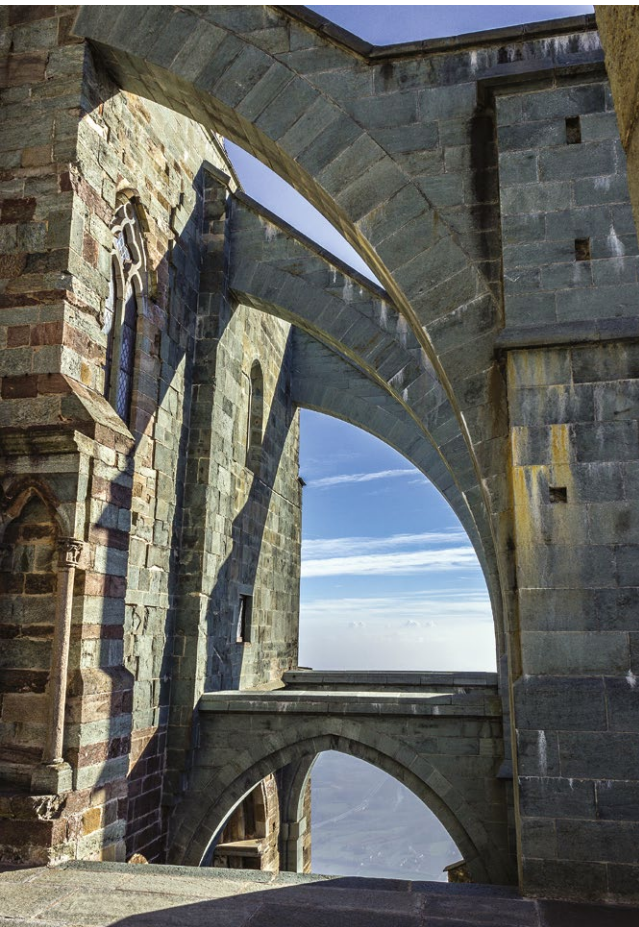
fig. 20 – Sacra di San Michele, archi rampanti sul lato meridionale (foto archivio autore).
