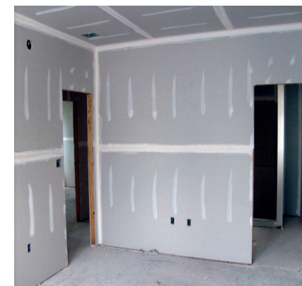
Applicazione del cartongesso da https://www.infobuild.it/approfondimenti/il-cartongesso-caratteristiche-e-impieghi-in-edilizia/
