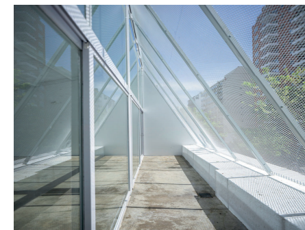
Frangisole in rete metallica: Casa Blas da https://www.adamo-faiden.com/
