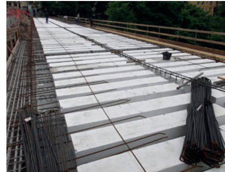
Elementi di alleggerimento per solai in EPS da https://www.sopreca.it/solai-prefabbricati/
