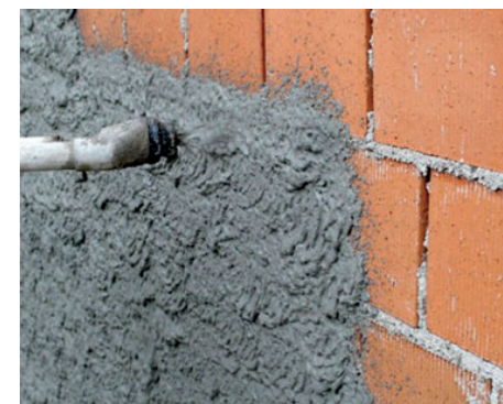
Applicazione di un intonaco composto da leganti idraulici da https://www.infobuild.it/approfondimenti/malte-e-intonaci-caratteristiche-e-impieghi-in-edilizia/
