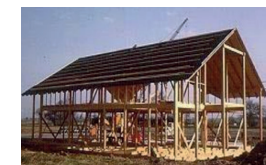
Struttura a telaio in legno da https://unikore.it/phocadownload/userupload/tiziana.basirico-unikore.it/Arch_Tec_Lez_09_struf%20elevazione.pdf
