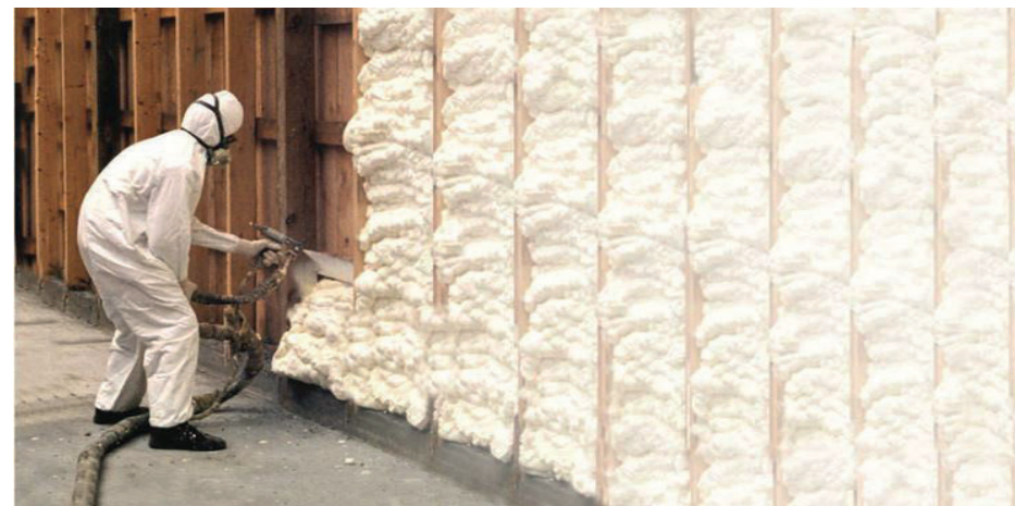
Applicazione di schiuma come isolante per una parete perimetrale da https://www.rifaidate.it/materiali-edili/materiali-per-edilizia/schiuma-poliuretana-a-spruzzo.asp
