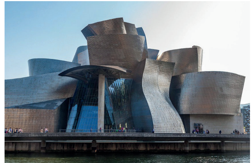
Guggenheim Museum a Bilbao, Spagna, Coperture in lega di titanio e zinco da https://www.bioedilprogetti.com/magazine/bilbao-la-citta-rigenerata-dal-guggenheim-museum/
