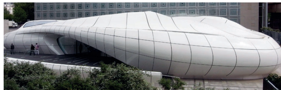
Chanel mobile art pavillon di Zaha Hadid, costituito da una struttura di pannelli rinforzati con fibre di vetro da https://socialdesigntagazine.com/mag/architettura/exhibit-pavilion-zaha-hadid/
