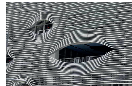
Facciata rivestita con frangisole orizzontali da https://www.afracom.fr
