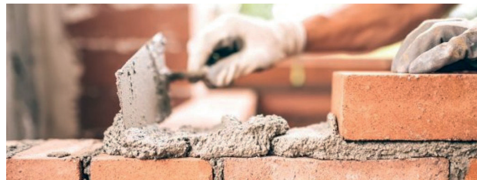
Fase di impiego in cantiere della malta bastarda da https://blog.edilnet.it/malta-bastarda-cosa-sapere/
