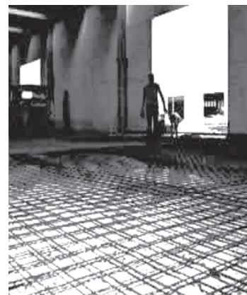
Solaio in cls armato da http://www.buildup.it/Documents/Portal/NotiziarioPittini/La%20rete%20elettrosaldada.pdf
