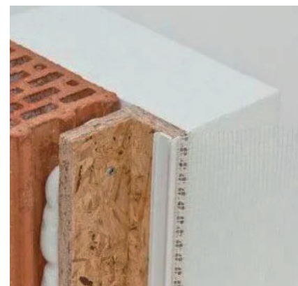
Controtelaio a "L" in legno (OSB) posato sulla muratura. Dall'immagine si nota la schiuma poliuretanica espansa insufflata nello spazio tra muratura e controtelaio, che poi verrà protetta con una barriera al vapore interna da https://www.posaqualificata.it/controtelaio-si-o-no/ , da https://it.win-direct.com/misure-con-controtelaio-da-murare/
