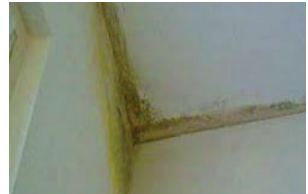
Muffe e batteri visibili a causa di un ponte termico da https://www.bioisotherm.it
