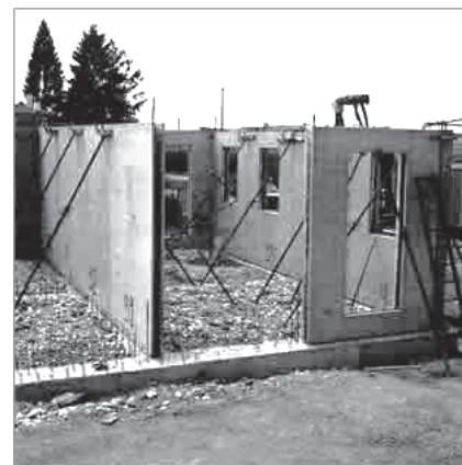
Muratura in cls armato da http://www.buildup.it/Documents/Portal/NotiziarioPittini/La%20rete%20elettrosaldada.pdf
