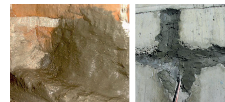
Impermeabilizzazioni con malte cementizie da https://www.diasen.com/sp/it/impermeabilizzanti-malte.3sp https://www.infobuild.it/prodotti/i-plug-malta-impermeabile/
