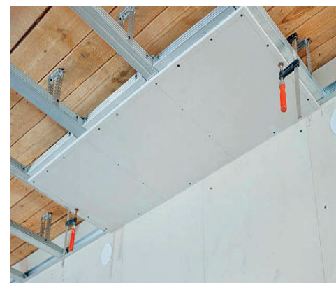
Applicazione del cartongesso da https://www.ilportaledellimbianchino.com/2318/guida-al-cartongesso-descrizione-tipologie-utilizzo-posa-costi/
