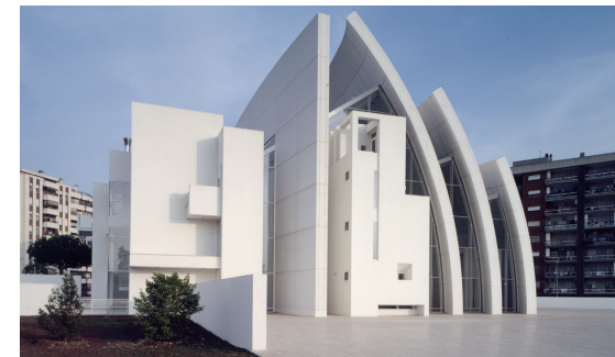
Richard Meier, Chiesa Dives in Misericordia, Roma, 2003. Esempio di edificio realizzato in cemento fotocatalitico da http://www.arcvision.org/dives-in-misericordia-5/
