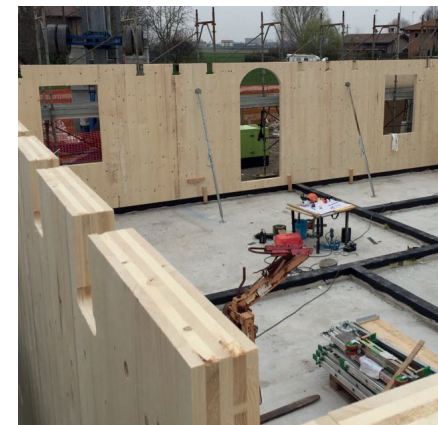
Pareti realizzate in legno xlam da https://www.casaattiva.com/wp-content/uploads/2018/03/IMG-20180328-WA0002.jpg
