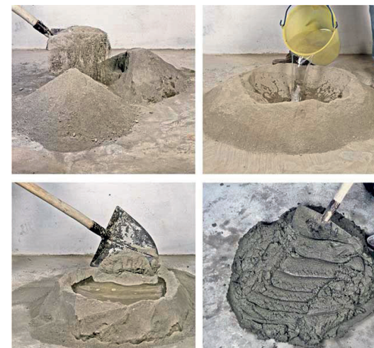
Fasi di lavorazione della malta cementizia da https://www.bricoportale.it/ristrutturare-casa/lavori-in-casa/muratura/malta-di-cemento/
