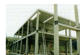
Telaio in cls armato da https://unikore.it/phocadownload/userupload/tiziana.basirico-unikore.it/Arch_Tec_Lez_09_struf%20elevazione.pdf
