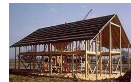
Struttura a telaio in legno da https://unikore.it/phocadownload/userupload/tiziana.basirico-unikore.it/Arch_Tec_Lez_09_struf%20elevazione.pdf
