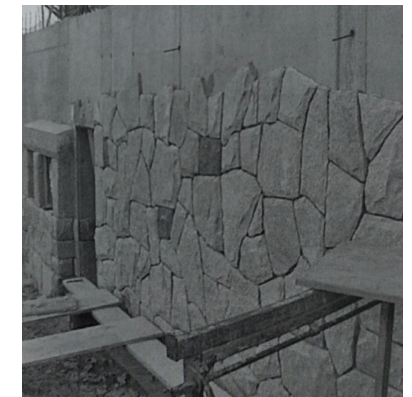
Posa in opera di un rivestimento in pietra su un sottostruttura metallica c.a. da Campioli A., Lavagna M. (2013), Tecniche e architettura , Città Studi
