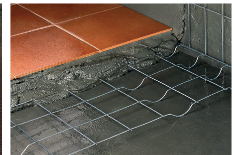
Massetto di sottofondo con rete metallica da https://www.artisticaposa.it/massetti/
