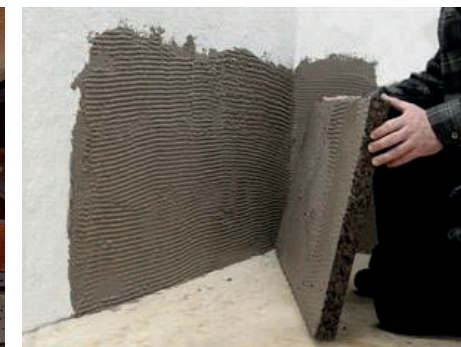
Applicazione di un pannello in sughero attraverso uno specifico collante da www.casaenergetica.it/info/tecnologia/materiali/sughero.html
