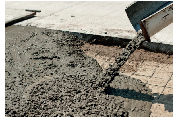
Getto in opera di calcestruzzo da http://www.infoacciaio.com/glossario/calcestruzzo/
