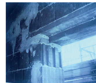
Vista di un Architrave in laterizio da Campioli A., Lavagna M. (2013), Tecniche e architettura , Città studi
