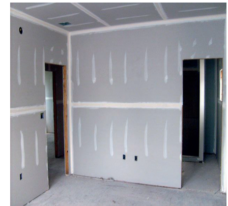
Applicazione del cartongesso da https://www.infobuild.it/approfondimenti/il-cartongesso-caratteristiche-e-impieghi-in-edilizia/
