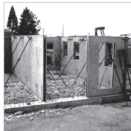
Muratura in cls armato da http://www.buildup.it/Documents/Portal/NotiziarioPittini/La%20rete%20elettrosaldada.pdf
