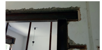
Esempio di una demolizione da https://www.officinadelfabbro.info/wp-content/gallery/travi/IMG-20150429-WA0024.jpg
