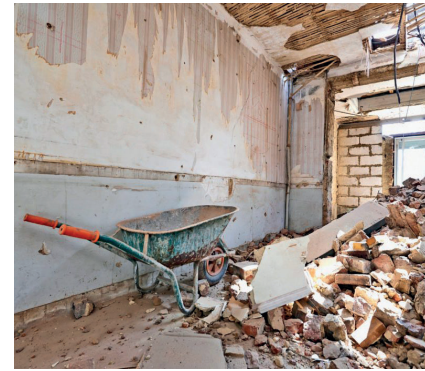
Demolizione da http://www.smeda.it/riciclare-inerti/demolizione-selettiva-smeda/
