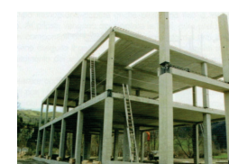
Telaio in cls armato da https://unikore.it/phocadownload/userupload/tiziana.basirico-unikore.it/Arch_Tec_Lez_09_struf%20elevazione.pdf
