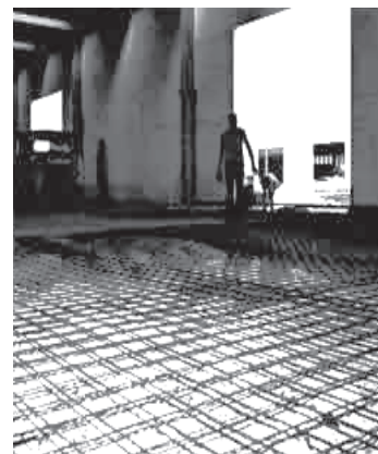
Solaio in cls armato da http://www.buildup.it/Documents/Portal/NotiziarioPittini/La%20rete%20elettrosaldada.pdf
