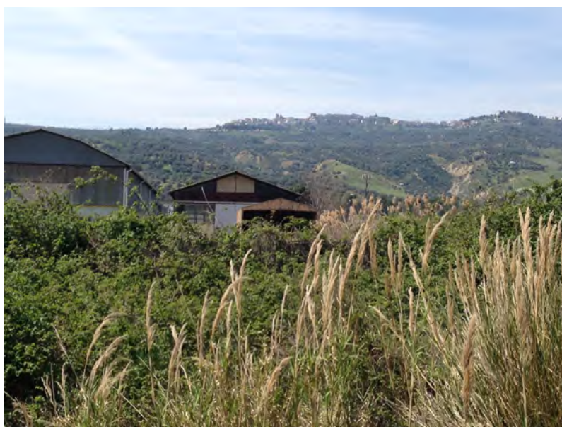
Figura 3 | Capannoni dismessi nella zona industriale di Ferrandina, Val Basento (MT). Fonte: rilievo diretto.
