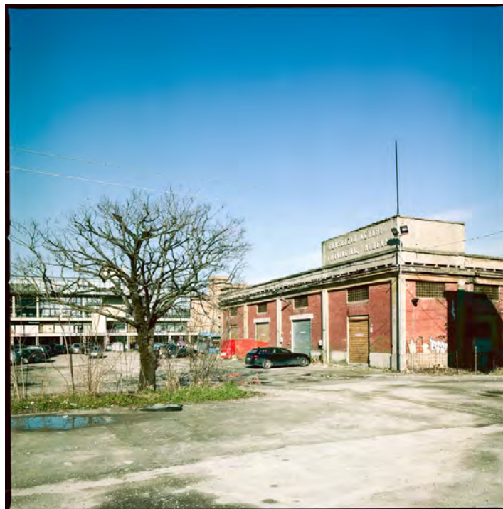
Figura 1 | L'ex-consorzio agrario, localizzato in pieno centro urbano, a fianco della stazione Modena-Sassuolo. Fonte: fotografia di Andrea Pirisi.
