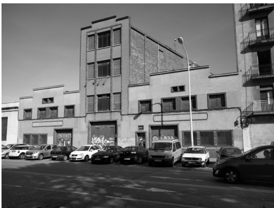
Figura 5 | Carrer Pere IV – Gli immobili industriali si dispongono sul fronte strada secondo il piano urbanistico del 1897 ma internamente contraddicono questa razionalizzazione secondo rapporti di proprietà derivanti dal tessuto storico del municipio di Sant Martí de Provençals . Fonte: Emanuele Protti.
