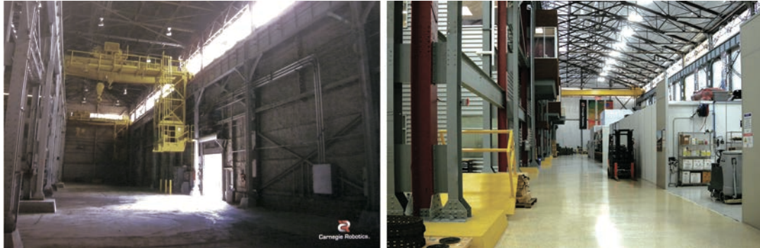
Figura 8 | Carnegie Robotics in una immagine prima dei lavori (a sinistra) e allo stato attuale (a destra). Fonte: immagine prima dei lavori cortesia di Carnegie Robotics, foto attuale a cura dell'autrice Caterina Montipò.
