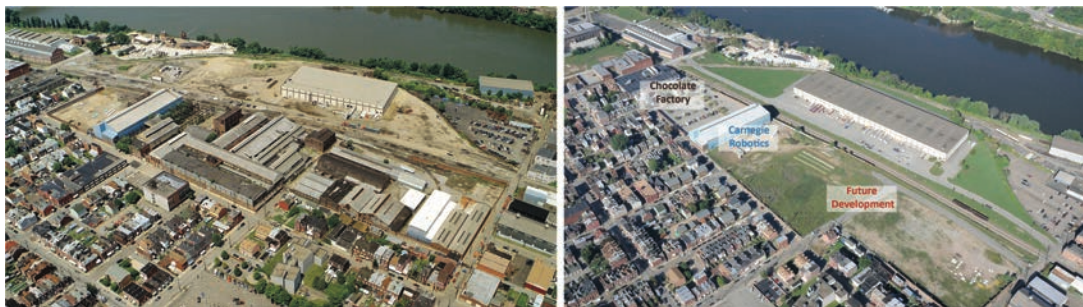
Figura 7 | Il sito del Lawrenceville Technology Center nel 2003 (a sinistra), prima dell'acquisizione della Heppenstall Steel Company, e nel 2014 (a destra) a lavori ultimati. Fonte: cortesia di RIDC.
