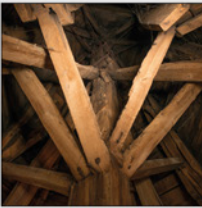
Fig. 3.1. Struttura lignea della guglia vista dal basso.
