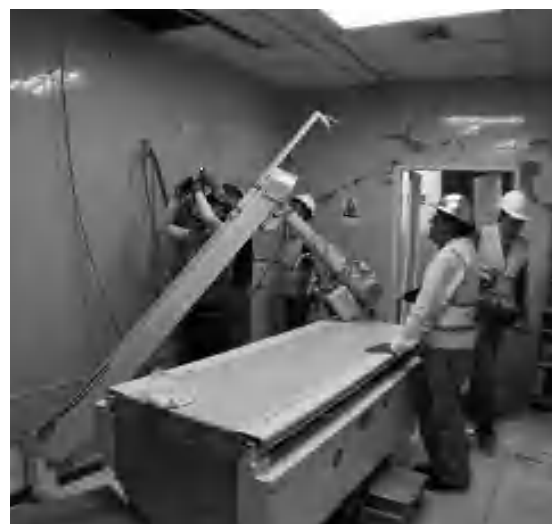
Foto 2. Hospital IESS de Manta internamente. Fuente: autores
