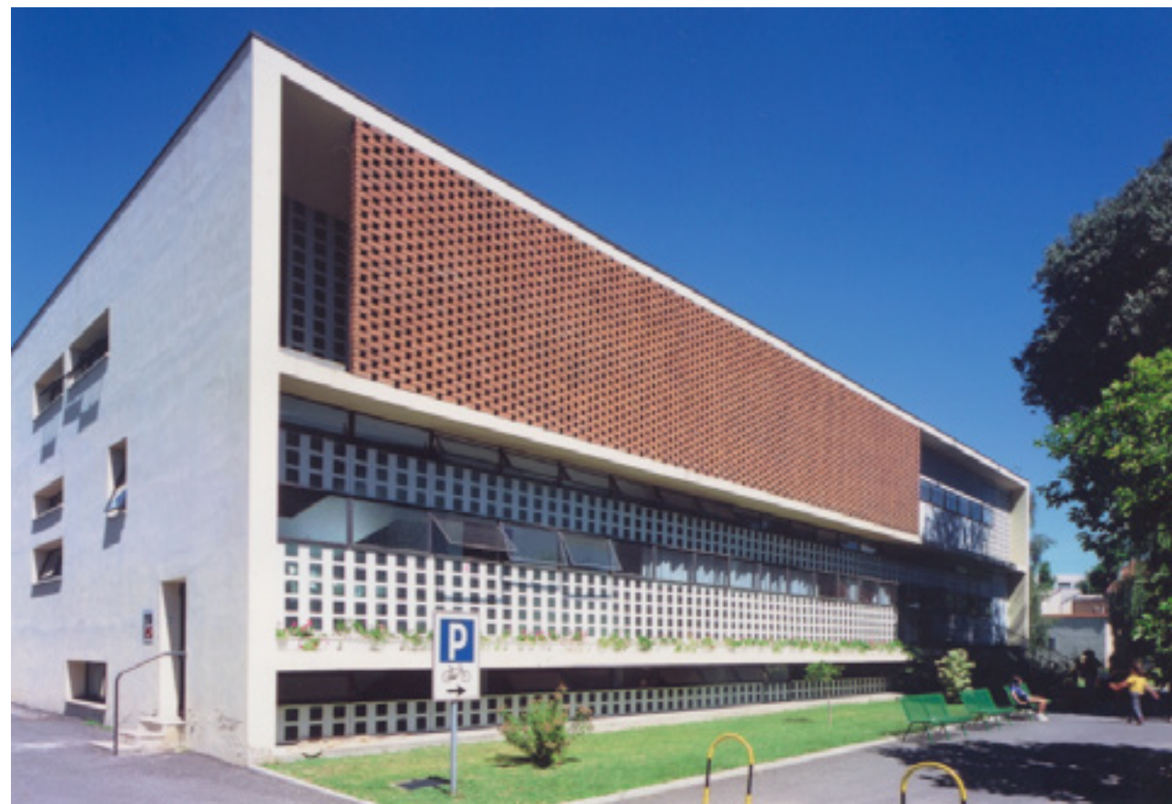
[ Figura 13. Il Dispensario antitubercolare, oggi poliambulatorio Gardella. ]
