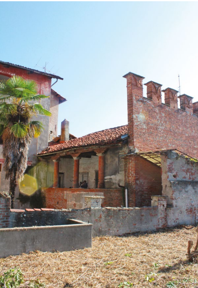
fig. 3 – Vista dal cortile interno rialzato, da cui si osservano i tre fabbricati che compongono il Palazzo dei Principi d'Acaja e parte della facciata che presenta le merlature (fotografia di G. Bergamo, ottobre 2016).
