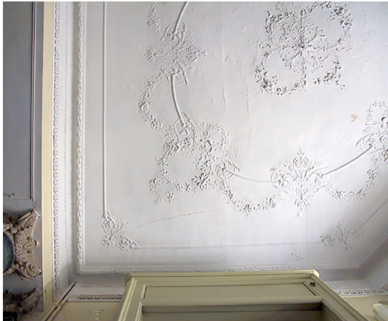
Fig. 10. Villa Zanelli, soffitto del salottino Maria Antonietta oggi crollato. Si è rilevato che gli stucchi erano dorati [fotografia dell'autore, 2020].
