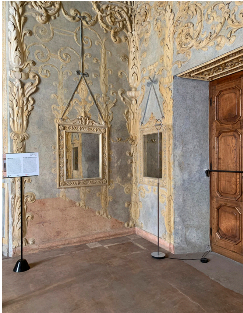
Figg. 8-9. Dettaglio del pavimento in cocciopesto e della decorazione a graffito, Gabinetto dei Fiori Indorato, Castello del Valentino, Torino [fotografia dell'autore, 2021].
