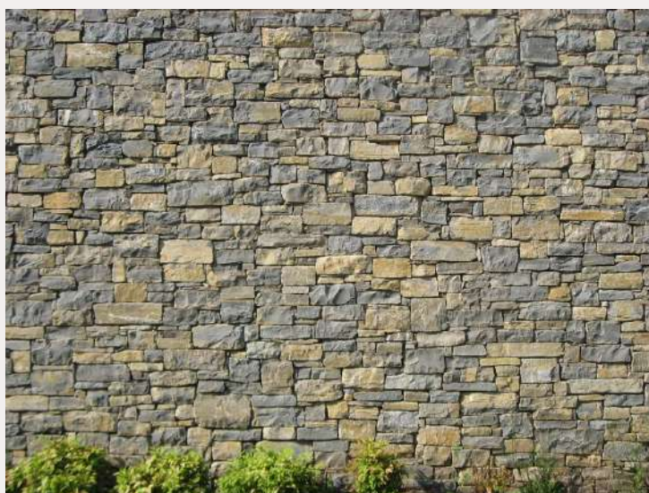
Fig. 5. Un muro a secco in conci di calcare di dimensioni medio-piccole, e scarsissimo impiego di malta interstiziale. Arzo (Svizzera)
