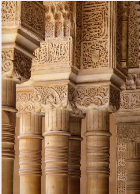
Fig 3. In passato la pietra, molto più di oggi, aveva una funzione portante, dovendo sostenere carichi in forma permanente. In queste situazioni la conoscenza della resistenza alla compressione è fondamentale [Alhambra di Granada, Spagna; marmo di Macael ]
