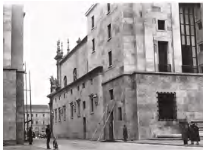
fig. 5 – Chiesa di Santa Cristina, fianco occidentale, 9 novembre 1937 (ASCT, Fondo Torino Anni Trenta, FT 08A05_012).
