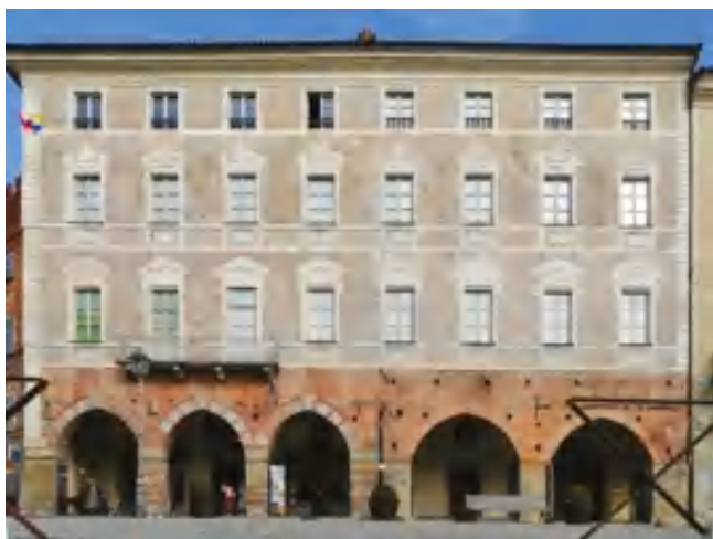
fig. 1 – Graffiti a marmorino sulla facciata di Palazzo Fauzone di Germagnano, via Vico, Mondovì. L'andamento delle aperture del portico denuncia la preesistenza di corpi edilizi distinti (fotografia di N. Rivero, 2020).
