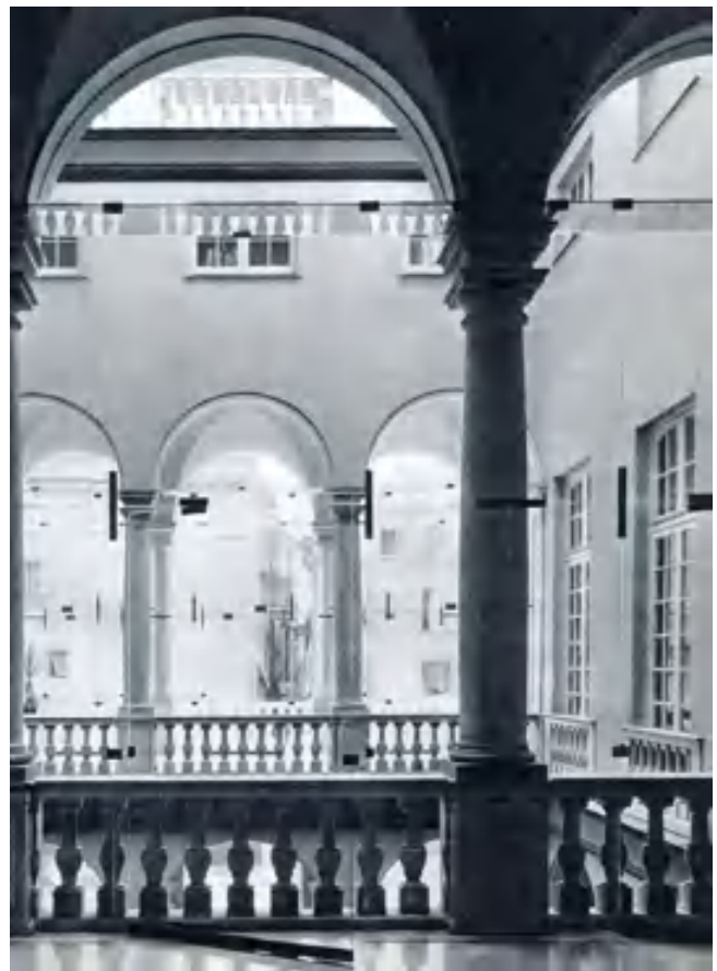
fig. 6 – Dettaglio delle chiusure verticali scelte da Albini per il loggiato di Palazzo Rosso, 1963 (da «Domus», n. 408, p. 43).
