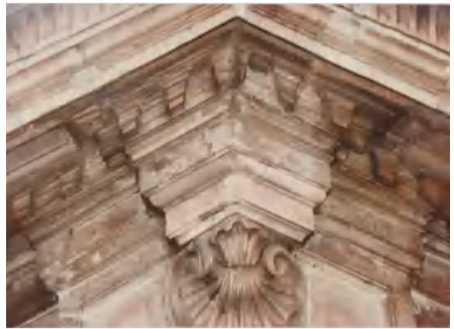
Fig. 13 – Documentazione fotografica prima dell'intervento di restauro, 1990 (SABAPTo, Archivio Restauri, ©SABAPTo tutti i diritti riservati).
