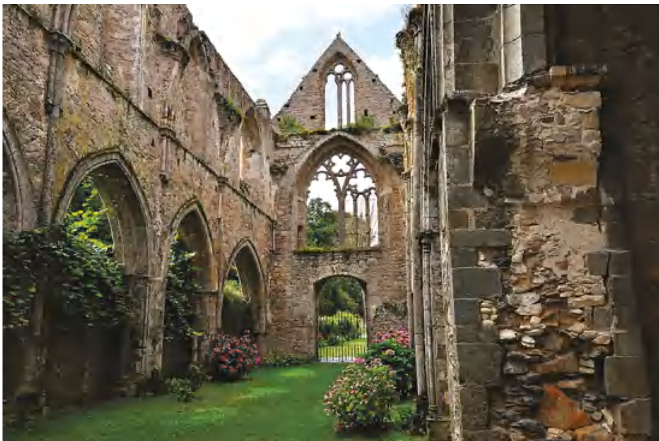
fig. 1 – L’abbaye de Beauport (Côtes-d’Armor), offre l’exemple d’un projet de conservation veillant à la protection du patrimoine historique et naturel. La conservation du site est gérée en collaboration par le Conservatoire du littoral et les collectivités locales (Crédits : Sullenski, CC-BY-SA, 2015).
