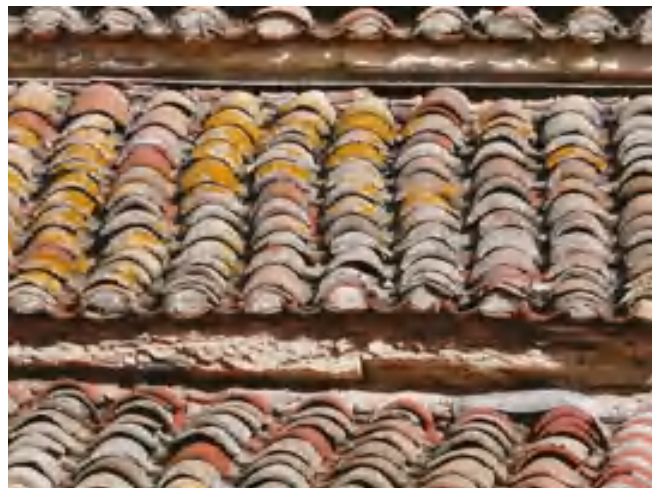
fig. 3 – Aigues-Mortes (Bouches-du-Rhône), couverture du bas-côté sud de l’église paroissiale, moutonnement irrégulier de tuiles vieilles (Cl. B. Phalip).
