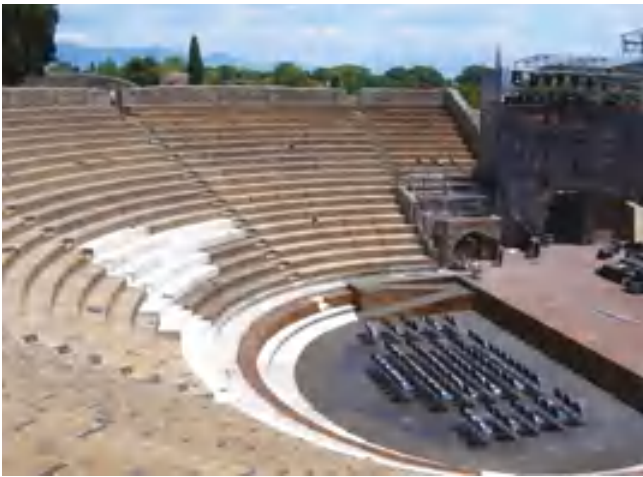
fig. 5 – Pompei: il teatro dopo gli interventi che hanno annullato il valore di autenticità del monumento, mortificando gli elementi originali a causa della massiccia integrazione delle parti nuove, spesso imitazione degli elementi architettonici antichi.
