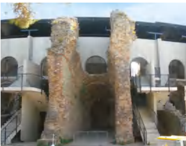
fig. 7 – Fréjus: l'intervento sull'anfiteatro, realizzato dall'architetto Flavigny, per rifunzionalizzare il rudere romano. La soluzione adottata impedisce la lettura dell'edificio originario andando contro ogni ragionevole visione di una corretta conservazione.
