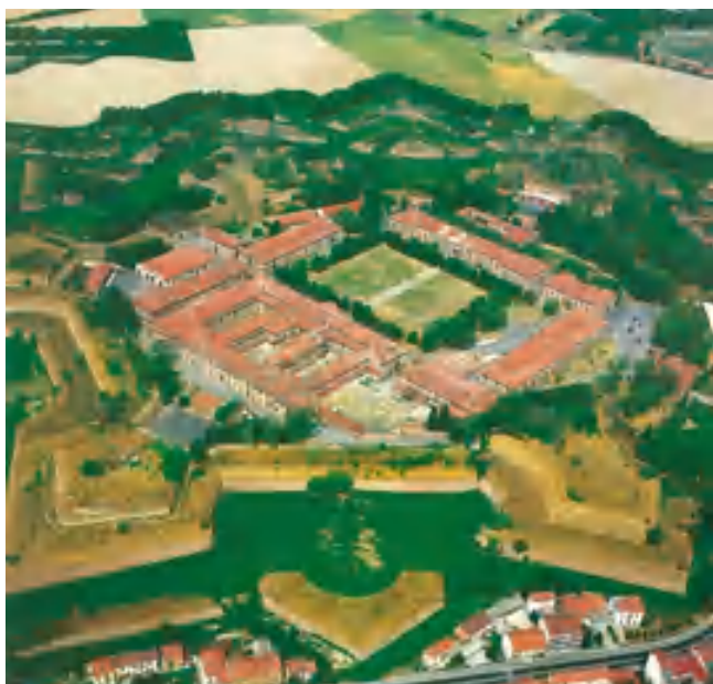
fig. 1 – La cittadella di Alessandria: dentro la cinta fortificata, in basso a sinistra il grande complesso edilizio del quartiere San Michele prospiciente l'omonimo bastione (fotografia di MAROTTA 1991, 37).
