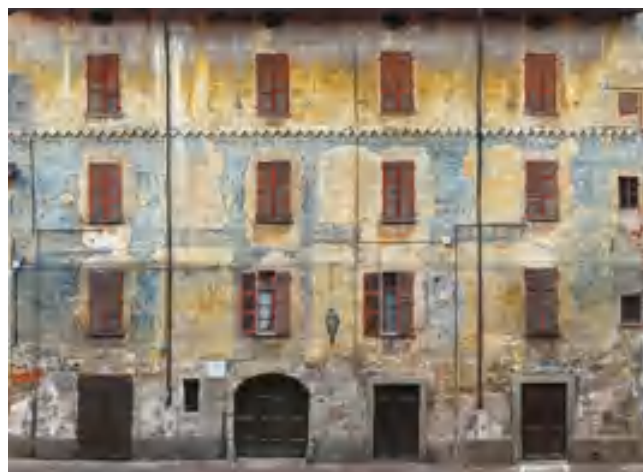
fig. 8 – Facciata esterna di Casa Maghelona, via Maghelona, Saluzzo (immagine ricostruita, N. Rivero, 2019).
