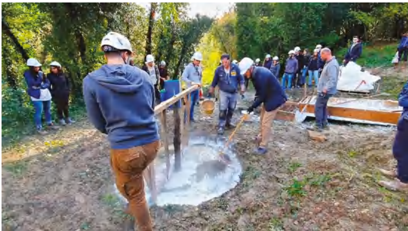
fig.5 – Archeologia sperimentale a Bagni di Petriolo: studenti e docenti dell’Università degli Studi di Firenze e di Siena, assistiti dagli operai del cantiere di restauro, alle prese con la produzione della malta attraverso modalità di lavorazione usate nel Medioevo (fotografia di G. Fenili).
