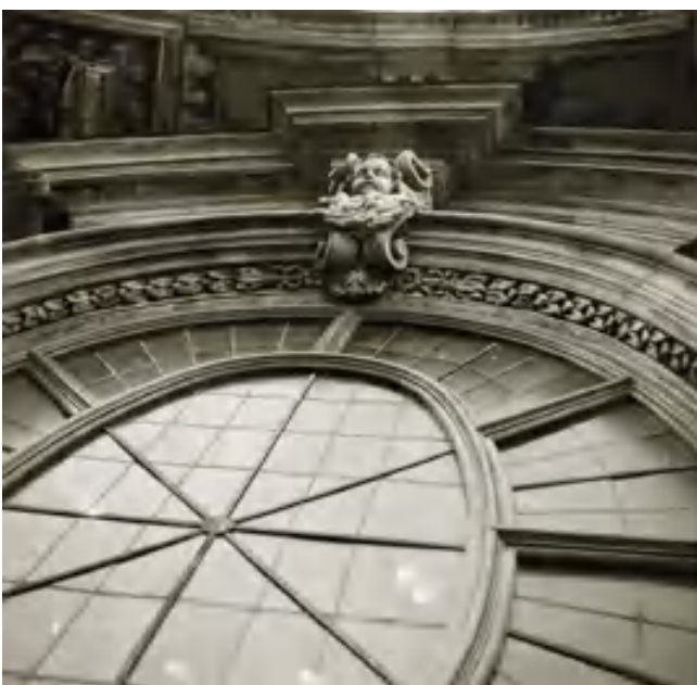
Fig. 9 – Torino, Piazza San Carlo – Chiesa di S. Cristina, particolari facciata – rosone, 1955 (SABAPTo, Archivio Fotografico, n. 10617b, ©SABAPTo tutti i diritti riservati).
