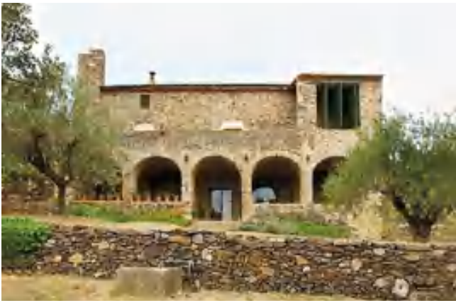
fig. 2 – Facciata principale di Casa Pairal (fotografia di Ana Rodriguez, http://joseantoniocoderch.org/casa-pairal ).
