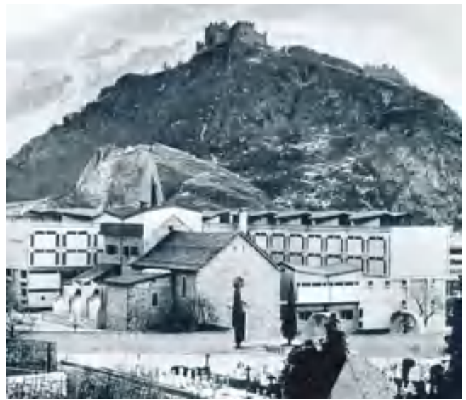
fig. 4 – Il rapporto tra antico e nuovo nel recupero del Convento francescano di Sion in seguito all'intervento di Mirco Ravanne, 1971 (da «Domus», n. 499, p. 17).
