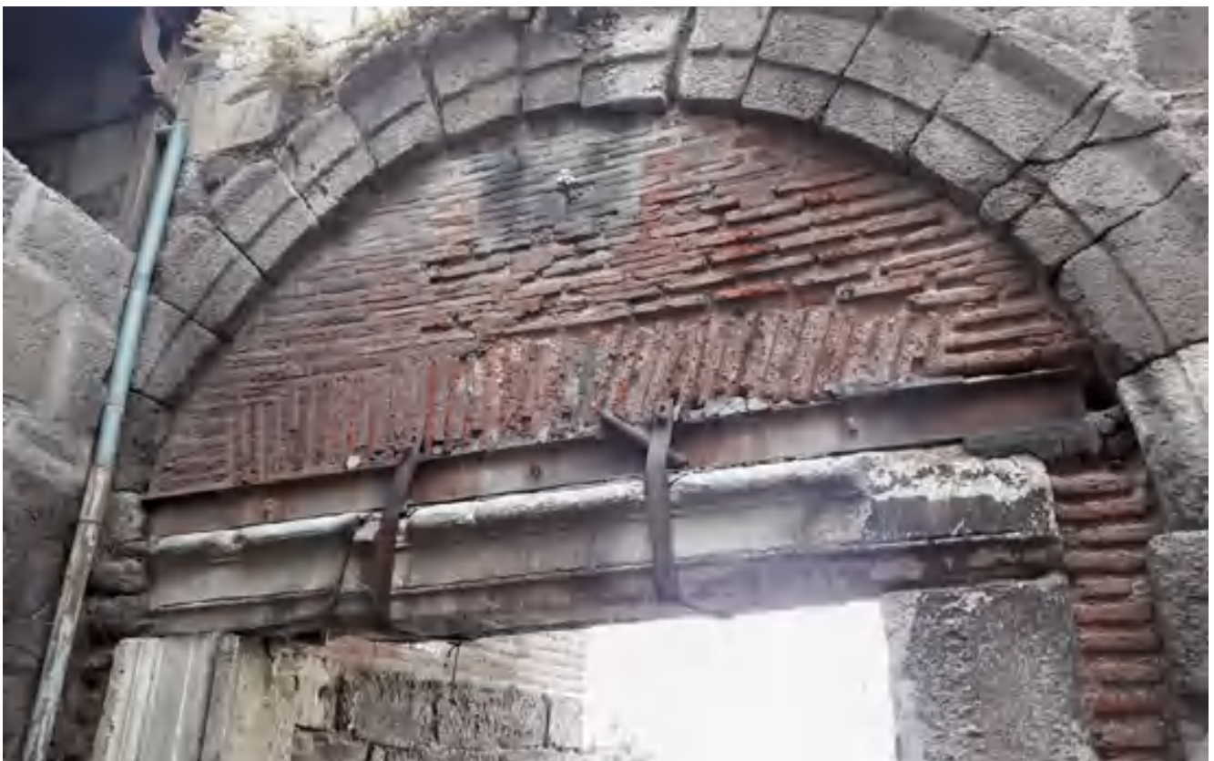
fig. 3 – Elementi classici inseriti nel nuovo portale di ingresso interno alla Cittadella e fagocitato da consolidamenti successivi.
