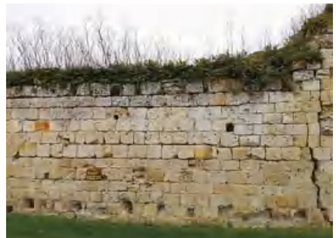
fig. 4 – Soft capping mis en place au début du XXème siècle. Courtine sud de la basse-cour du château de Coucy (Aisne) (Crédits : M. Méchineau, CC-BY-SA, 2020).
