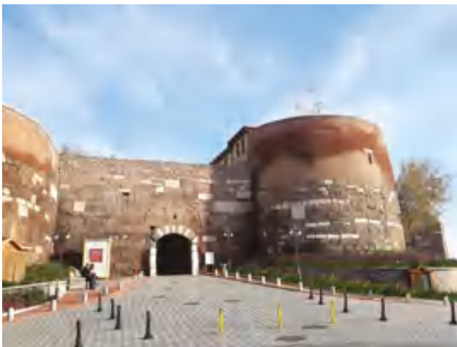
fig. 1 – Riuso dei rocchi di colonne classiche nei torrioni circolari delle mura esterne.
