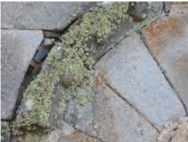
fig. 9 – Prieuré de Bredons (Albepierre-Bredons, Cantal), fin du XII e siècle, moulure d'archivolte d'une baie du chevet, cyanobactéries (surfaces ombrées), lichens crustacés (orange), lichens foliacés (gris) et fruticuleux (vert clair), l'ensemble n'a fait l'objet d'aucune restauration (Cl. B. Phalip).
