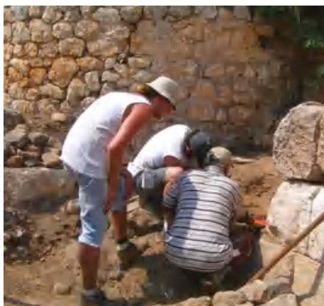
fig. 19 – Elaiussa Sebaste: i primi interventi di ricostruzione delle murature crollate. Le operazioni hanno previsto esclusivamente la ricollocazione del materiale lapideo in evidente stato di crollo primario.
