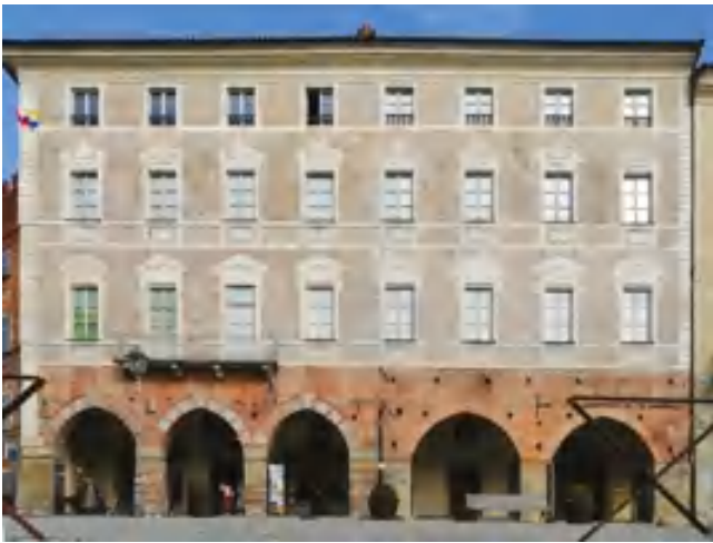
fig. 1 – Graffiti a marmorino sulla facciata di Palazzo Fauzone di Germagnano, via Vico, Mondovì. L'andamento delle aperture del portico denuncia la preesistenza di corpi edilizi distinti (fotografia di N. Rivero, 2020).
