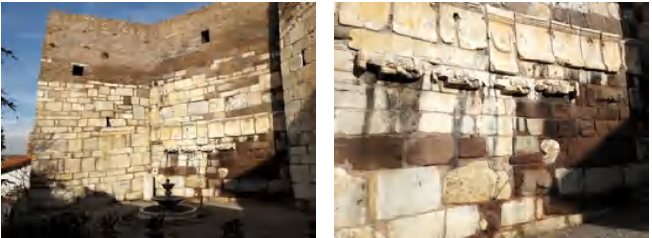
figg. 4-5 – Utilizzo di blocchi con altorilievi antropomorfi nella muratura della Cittadella. Si noti la differente posa rispetto al verso originario e la privazione delle caratteristiche facciali o l'acefalia delle figure.
