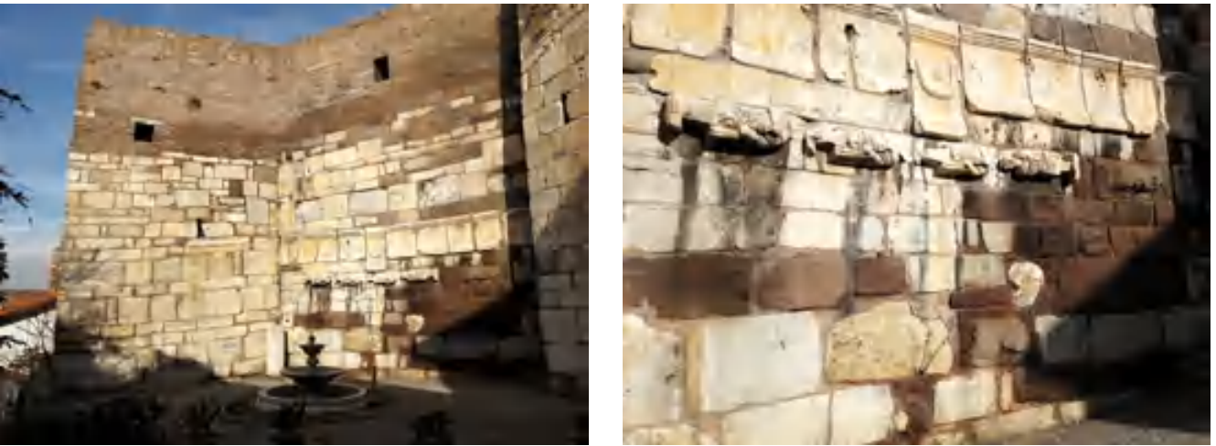
figg. 4-5 – Utilizzo di blocchi con altorilievi antropomorfi nella muratura della Cittadella. Si noti la differente posa rispetto al verso originario e la privazione delle caratteristiche facciali o l'acefalia delle figure.
