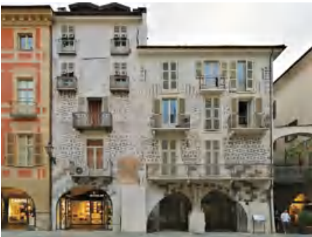
fig. 2 – La facciata di Casa Miraglio e Casa Tua, via Roma, Cuneo (fotografia di N. Rivero, 2020).
