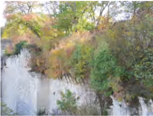
fig. 8 – Chinon (Indre-et-Loire), château, front Nord, rempart couvert d'humus et de végétation depuis deux siècles, abandon au XVI e siècle et transformation en parc en 1824, les racines sont rampantes, les végétaux sont à l'origine d'un paléosol, l'ensemble doit faire l'objet d'une surveillance attentive et d'un jardinage des ruines ; cet équivalent naturel du soft capping possède une résistivité plus forte que la pratique du hard capping avec reprise maçonnée du sommet des murs (Cl. B. Phalip).
