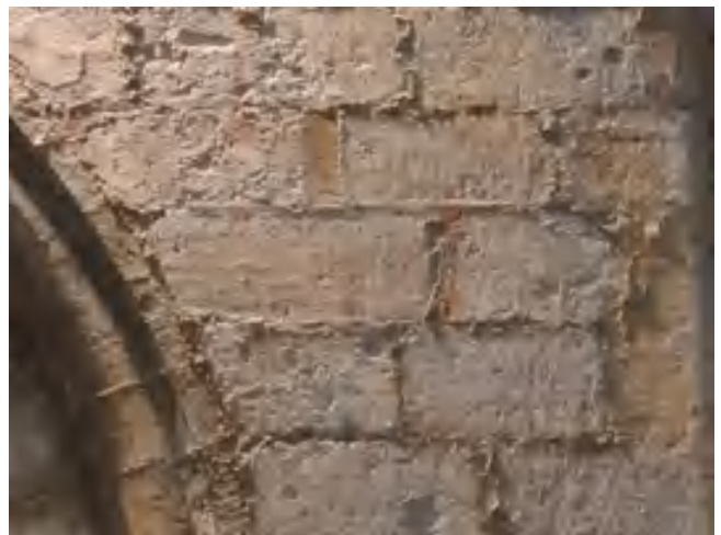
fig. 2 – Saint-Père de Chartres, détail de l’appareil interne sud de la nef, traces de taille et de badigeons, joints d’origine (XIII e ) et disparité des teintes, les lumières naturelles jouent en éclairage rasant sur les surfaces rugueuses (Cl. B. Phalip).
