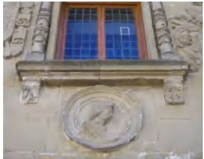
fig. 10 – Detalle del alfeizar, intervención de Torres Balbás, Casa del Pópulo, Baeza.
