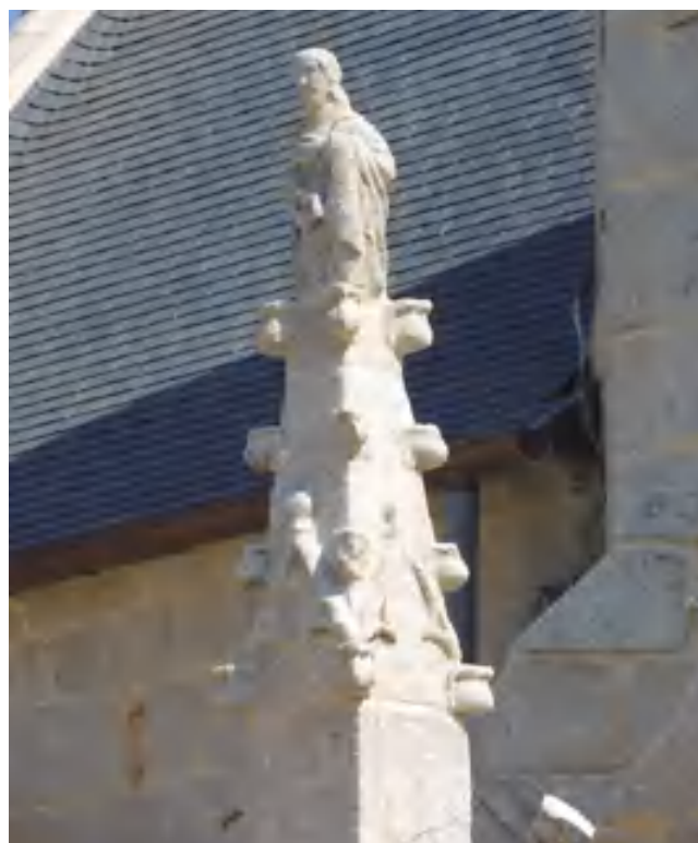
fig. 7 – Forêt-Fouesnant (Finistère), église paroissiale des XV e et XVI e siècles, restauration (2019), après nettoyage des granits, épiderme fragilisé, surfaces nues, une à deux années après les micro-algues envahissent et verdissent les sculptures (Cl. B. Phalip).
