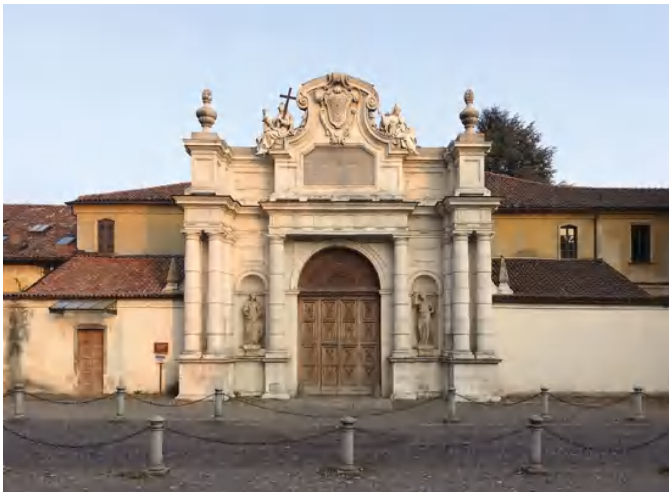
fig. 3 – Portale monumentale d'ingresso su disegno di Filippo Juvarra. La fotografia rappresenta lo stato attuale, dopo il restauro del 2000 promosso dal Comune di Collegno in partenariato con la Regione Piemonte (fotografia di Agaliati-Galfo, ottobre 2019).
