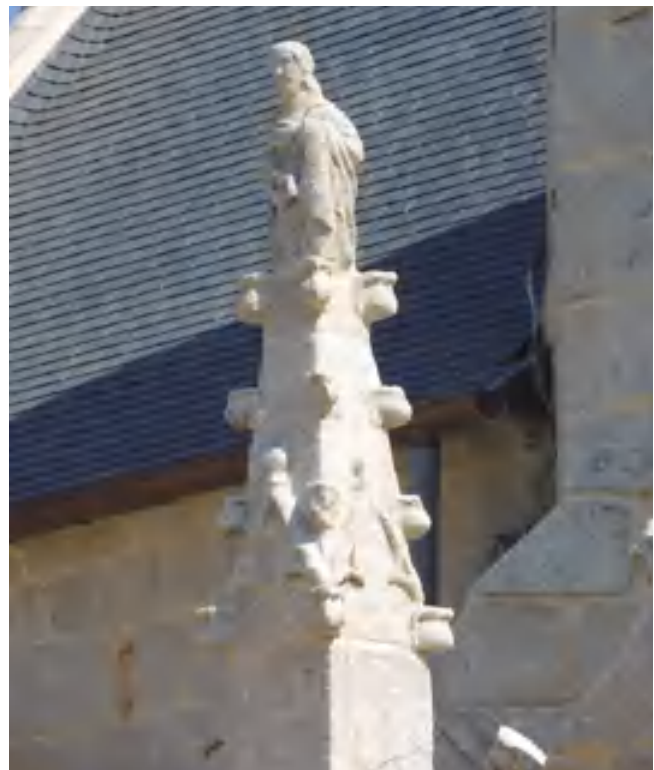
fig. 7 – Forêt-Fouesnant (Finistère), église paroissiale des XV e et XVI e siècles, restauration (2019), après nettoyage des granits, épiderme fragilisé, surfaces nues, une à deux années après les micro-algues envahissent et verdissent les sculptures (Cl. B. Phalip).
