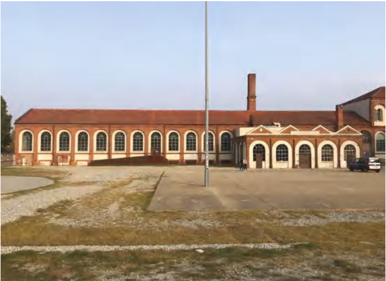
fig. 4 – Lavanderia a vapore, stato attuale. La corte interna divenuta arena per gli spettacoli musicali all’aperto (fotografia di Agaliati-Galfo, 8 febbraio 2020).
