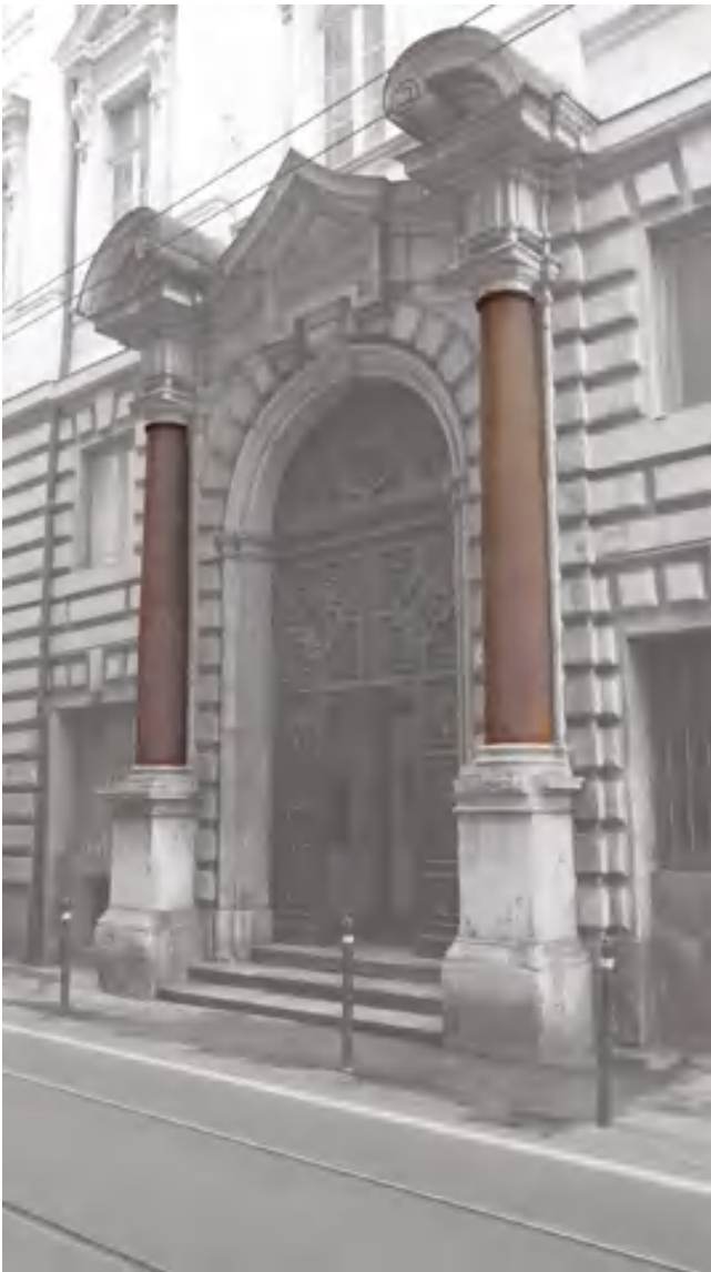
fig. 2 – Il portale del Seminario Metropolitan di Torino sull’attuale via XX Settembre, già Contrada del Seminario: L’effetto cromatico mira a evidenziare gli elementi in granito (fotografia ed elaborazione dell’autore).
