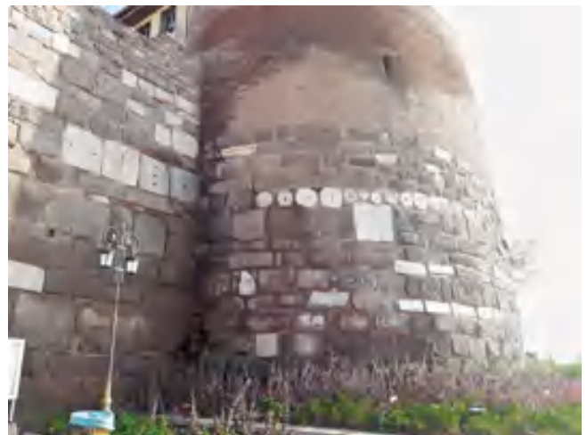
fig. 2 – Dettaglio della nuova tessitura muraria nei torrioni delle mura esterne.
