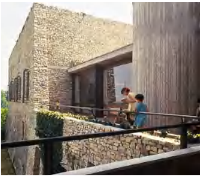
fig. 3 – Connessione tra antica e nuova struttura nel recupero del castello medievale sul colle Mucciatella (fotografia Studio Canali Associati).
