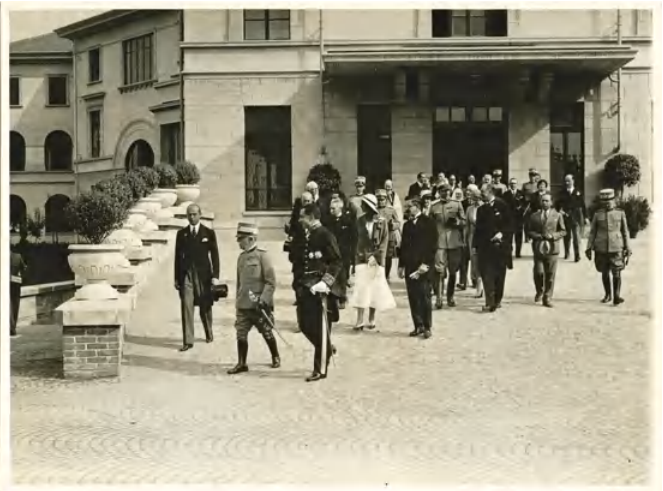
fig. 20 – STUDIO OTTOLENGHI, Visita dei reali d'Italia in occasione del completamento dei lavori dell'ampliamento dell'Ospedale Umberto I in Torino [1931?] (AOM, Fondo fotografico , busta 42). Stampa su carta alla gelatina a sviluppo.
