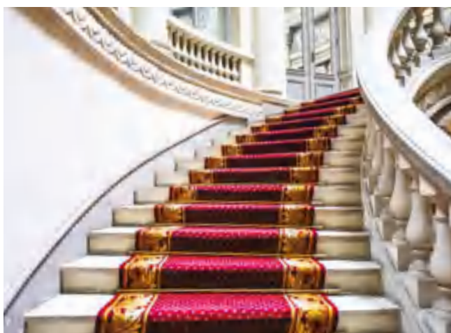
fig. 4 – Dettaglio della rampa dello scalone d'onore (©Nicola Vigilanti, 2020).
