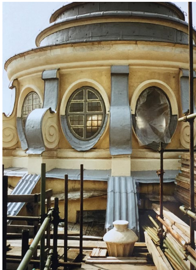
Figura 8. La lanterna della cappella della Sindone, circa 1995. Sopralluogo e fotografia durante i lavori di manutenzione: una opportunità per raggiungere luoghi altrimenti non praticabili e impostare il rilievo di parti complesse e comprendere le opere di completamento. © Fondo Franco Rosso, Archivio di Stato di Torino.
