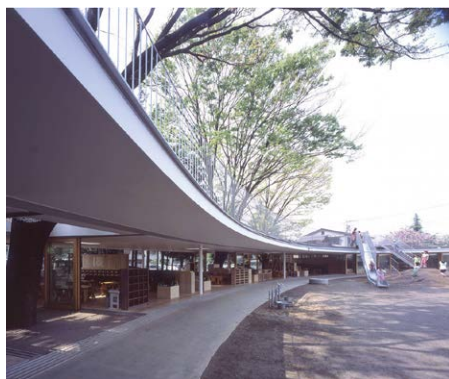
Corte interna intorno alla quale si sviluppano le aule in diretto collegamento con lo spazio esterno
