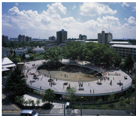
Vista aerea della scuola che mostra la copertura percorribile
