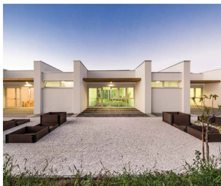
Vista di alcune aule dall'esterno del cortile annesso alla scuola
