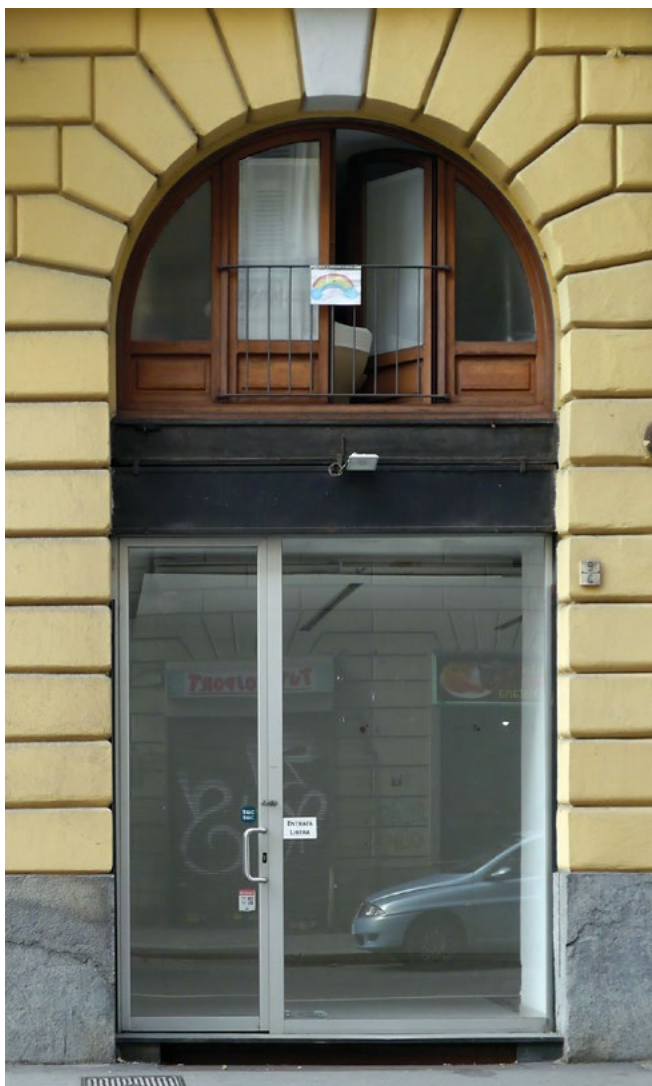
Figura 12. Casa Antonelli, via Vanchiglia (foto di Gianfranco Cavaglià, novembre 2020). Protezione da cadute, ringhiera in corrispondenza delle sole parti apribili: un elemento costruttivo di Antonelli. L'infisso al piano terra sostituito con infisso metallico: mancano strumenti per vincolare il mantenimento di quelli originali.
