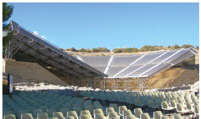
fig. 4 – Eraclea Minoa: il teatro magnogreco dopo l'eliminazione delle protezioni realizzate da Francesco Minissi e la costruzione della nuova copertura.
