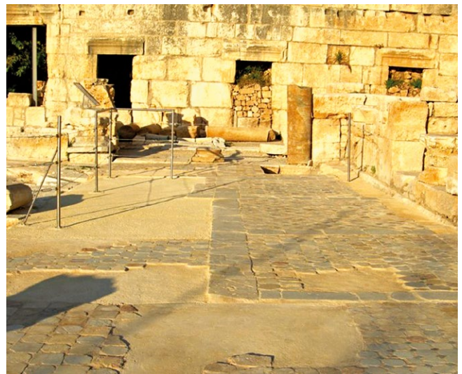
fig.23 – Elaiussa Sebaste: veduta dell'agorà dopo gli interventi di restauro dei ruderi e delle pavimentazioni di età romana e della fase bizantina quando il complesso diventò basilica cristiana.
