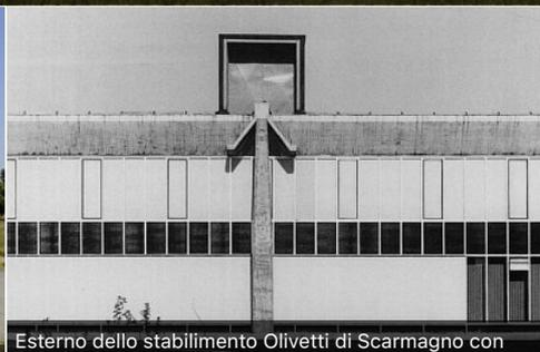
Esterno dello stabilimento Olivetti di Scarmagno con particolare del sistema trave-pilastro a 'Y' rovesciata (© AA\_visiting school)
