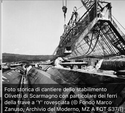
Foto storica di cantiere dello stabilimento Olivetti di Scarmagno con particolare dei ferri della trave a 'Y' rovesciata (© Fondo Marco Zanuso, Archivio del Moderno, MZ A FOT S37/1)
