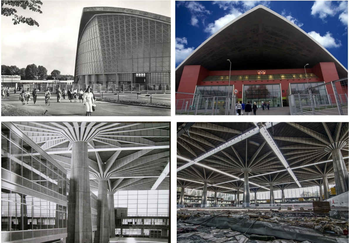
Figure 0.1: (a) Annibale e Giorgio Rigotti, Palazzo a Vela, via Ventimiglia 145, Torino, 1961. A sinistra Cartolina datata 1961, a destra foto del 2018. (b) Pierluigi e Antonio Nervi, Palazzo del Lavoro, via Ventimiglia, 211, Torino, 1961. A sinistra foto del 1965, destra foto del 2018 (Fonti e crediti: (a) Sinistra: AtlasFor, (a) Destra: foto propria, (b) Sinistra: Il giornale dell'architettura "Cronistoria di una vita grama: il Palazzo del Lavoro dal 1961 a oggi", 20 settembre 2015, (b) Destra: ZaziRound)
